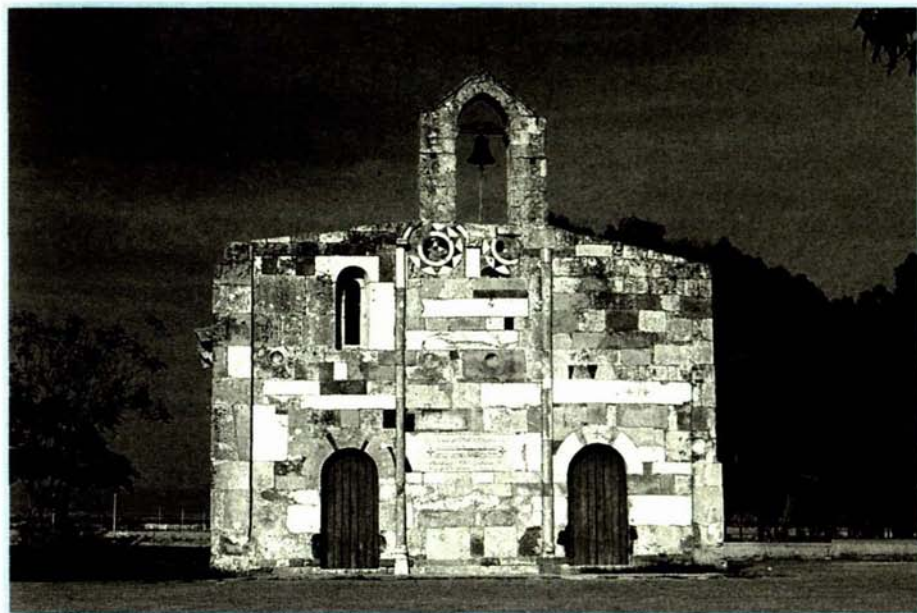
Fig. 13 Villaspeciosa (CA), San Platano, facciata.
