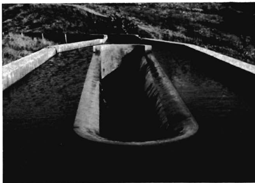
Sfioratore a monte del tripartitore
