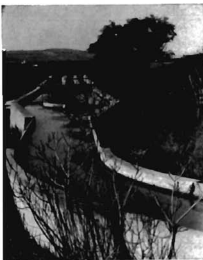
Terminale del derivatore e tripartitore
