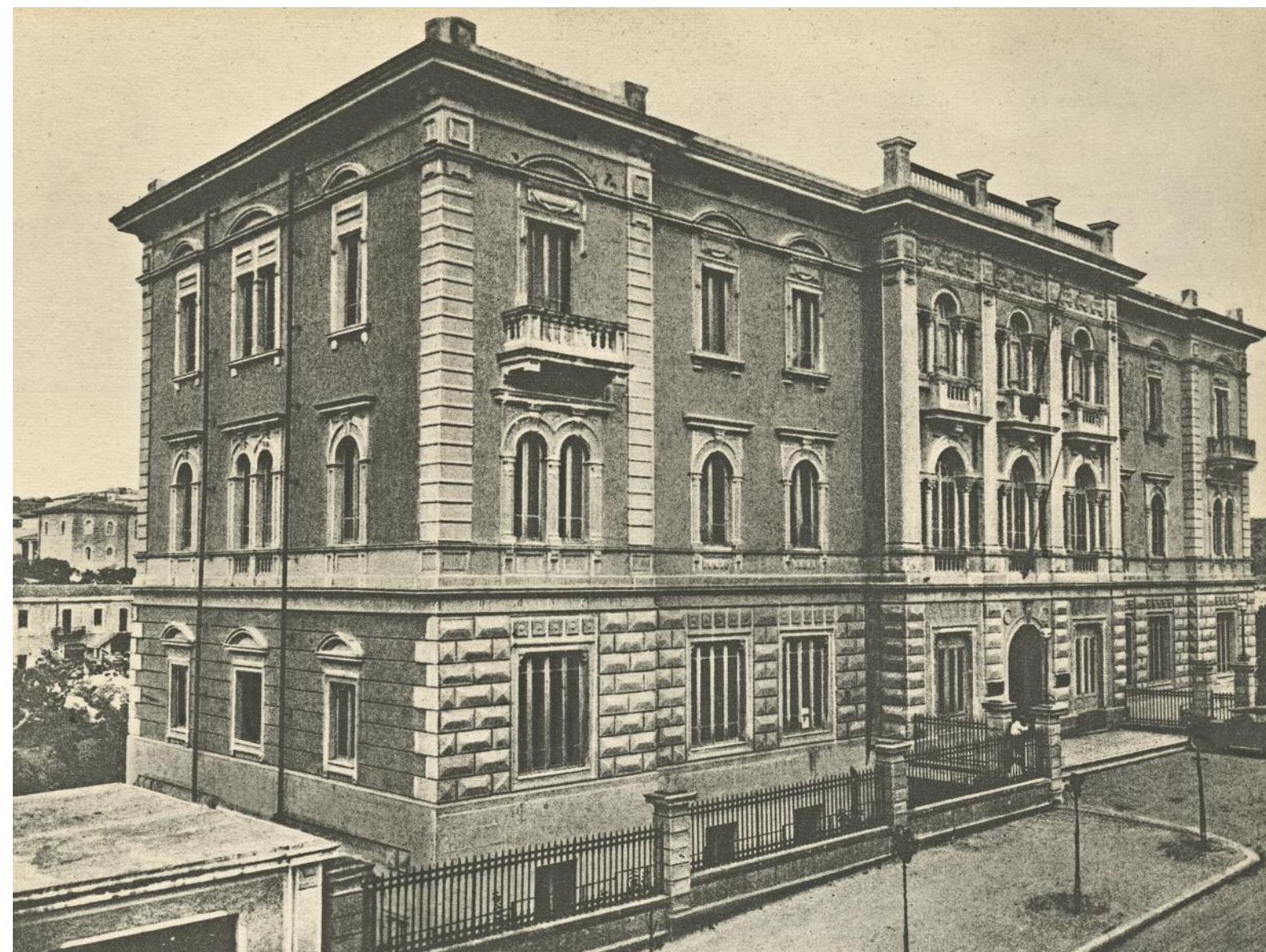
La facciata del palazzo del Consiglio Provinciale delle Corporazioni dell'ingegnere Bruno Cipelli, in una foto tratta da Opere pubbliche. Rassegna dello sviluppo dell'Italia imperiale , Roma 1937 (Sassari, collezione privata)
