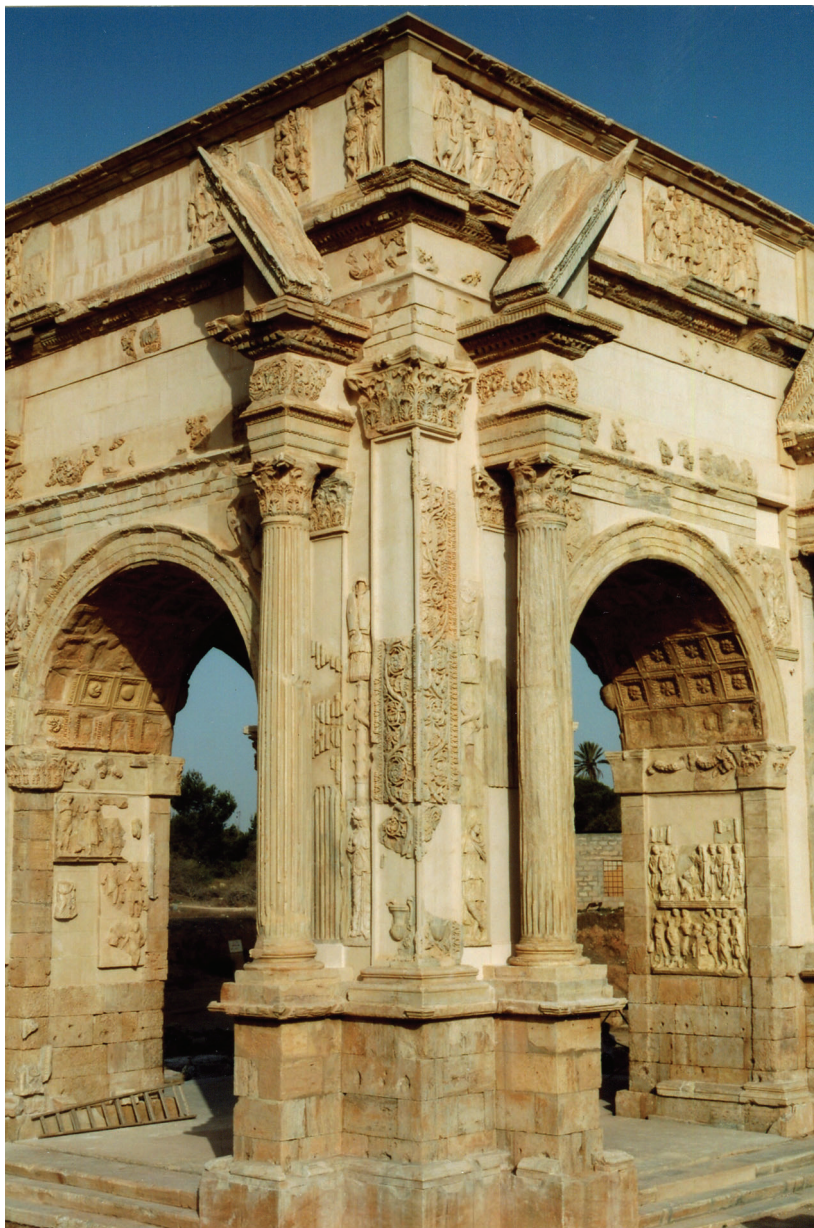
Pilone est e rilievi interni sui piloni nord e sud, a restauro finito (2004).
