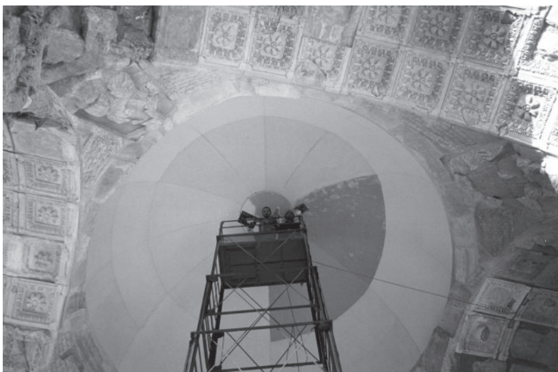
Fig. 4: a) Le lesene dell'ordine minore durante la ricomposizione; b) la cupola in vetroresina.
