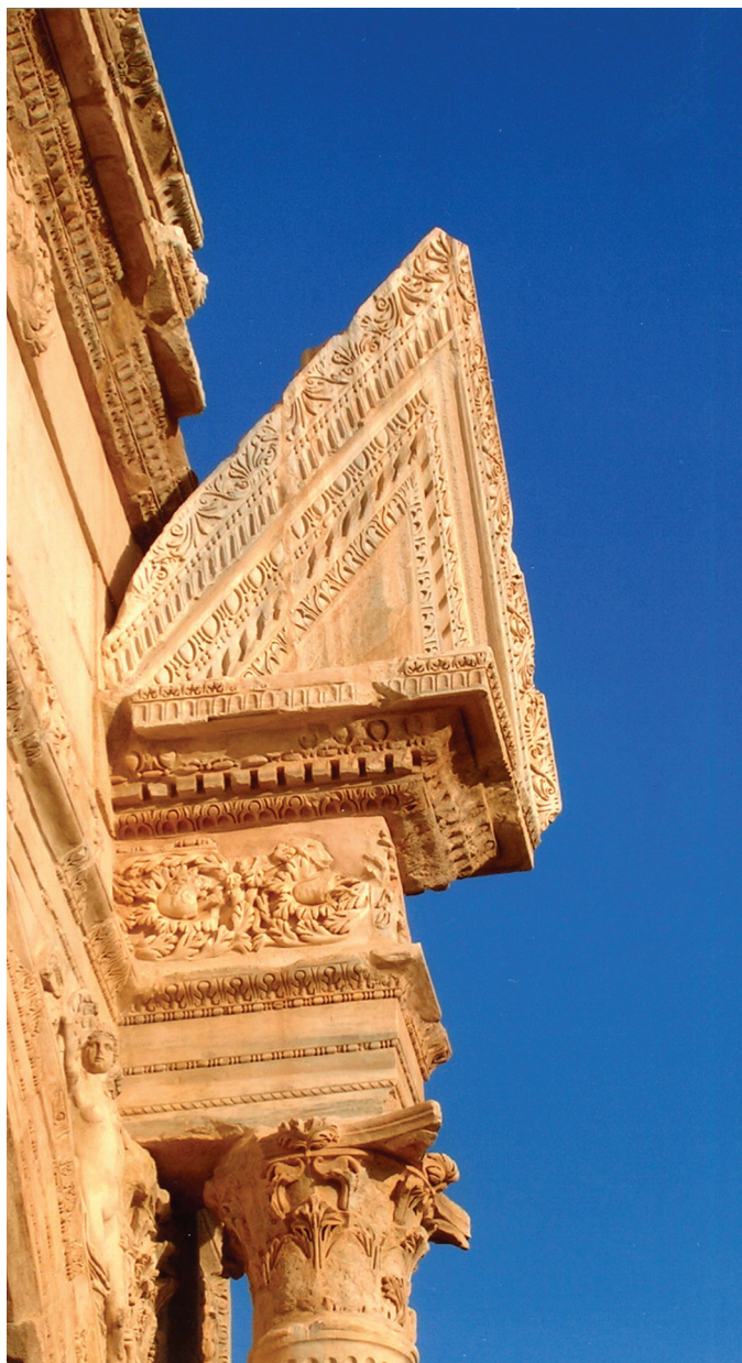
Dettagli della decorazione architettonica a restauro completato (2004).
