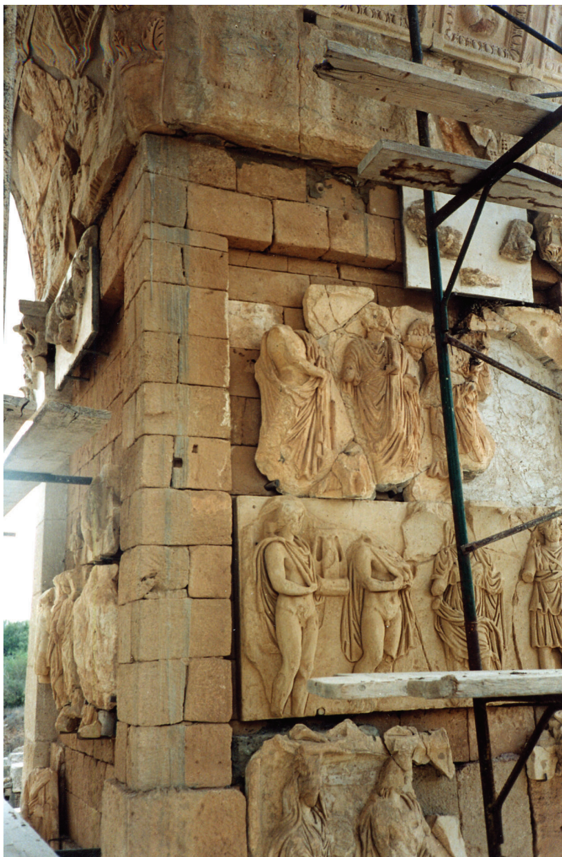
Rilievi interni, pilone est, pannello sud-ovest, durante il restauro.
