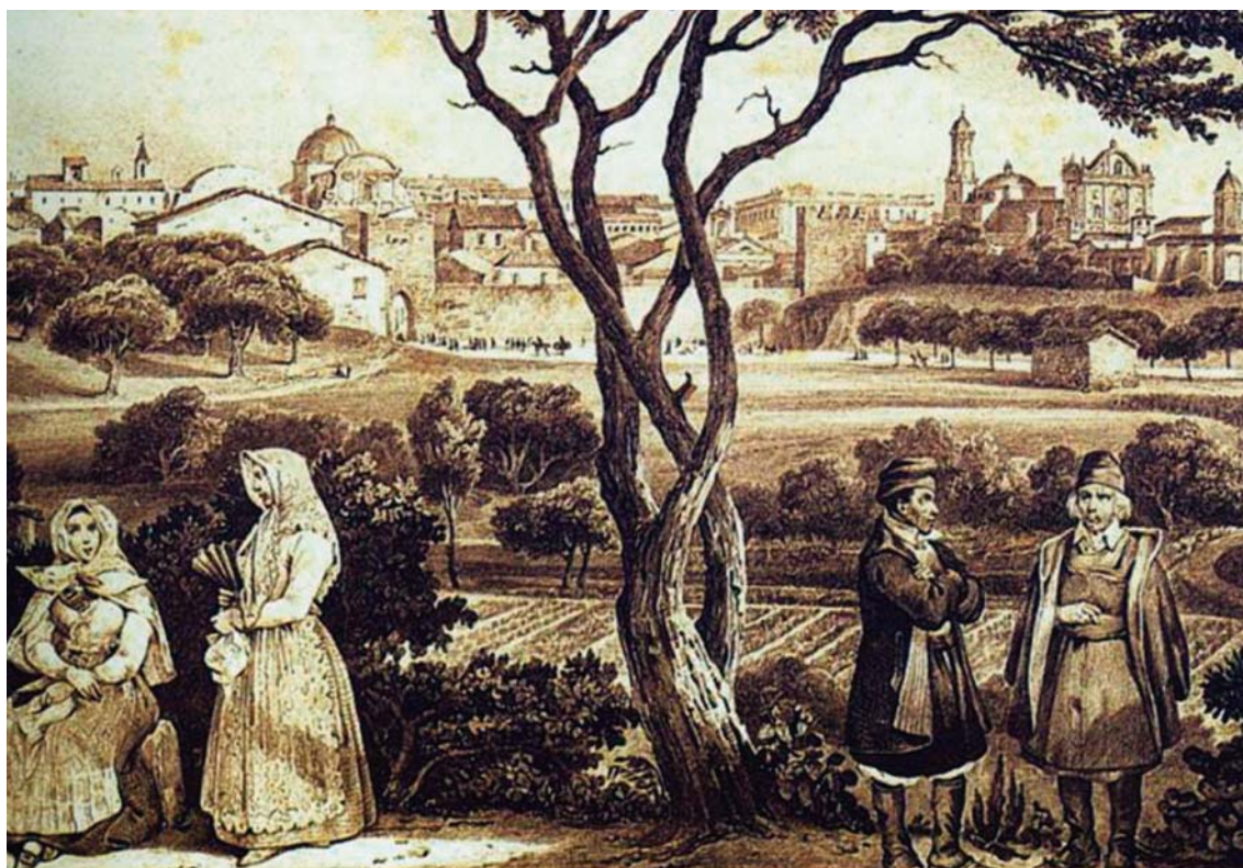
Figura 1 - L'ingresso a Sassari in una veduta del Cominotti (Fauli, 2005)
