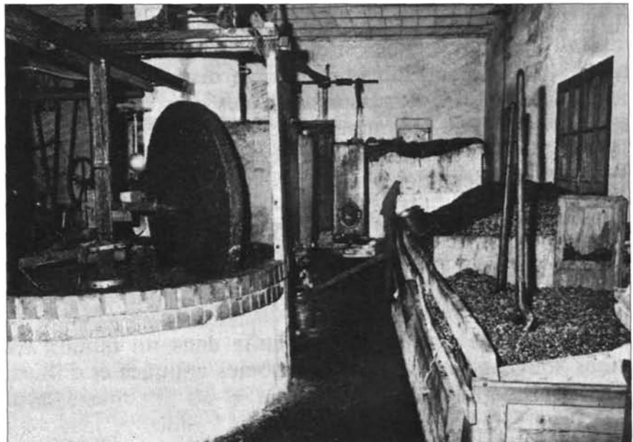
Fig. 12. 9. I compartimenti lignei che contengono le olive da sottoporre a molitura dell'oleificio tradizionale di Solliès-Ville (da: BRUN 1986, 50, fig. 5).
