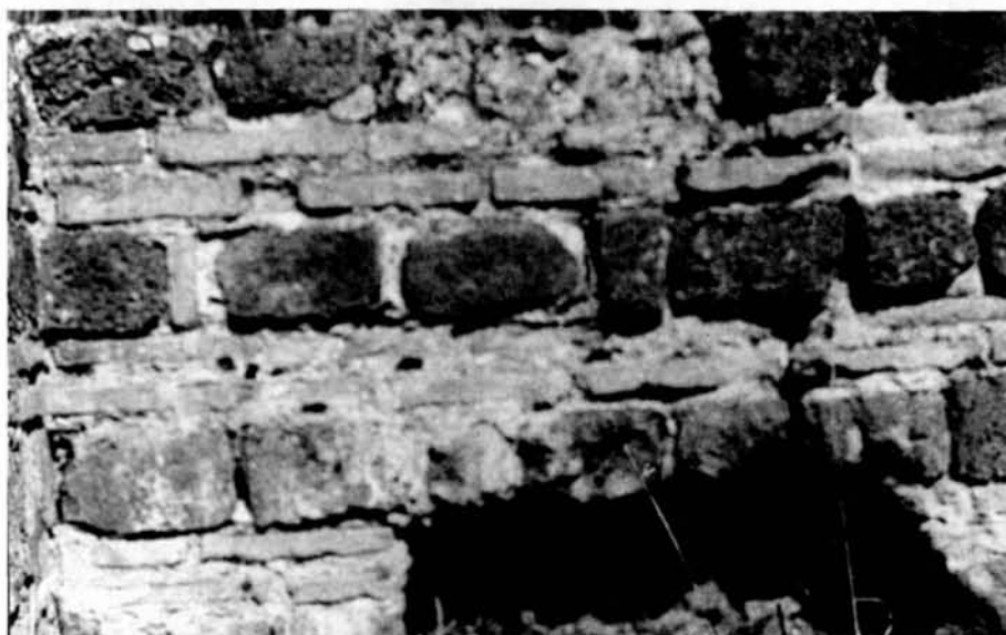
Foto 8 - Santulussurgiu. Tepidarium in località Banzos - particolare.
