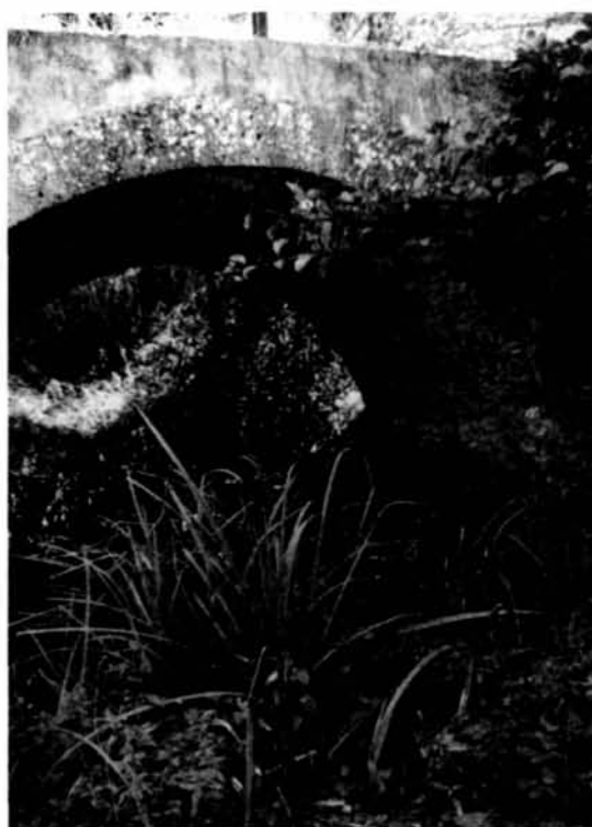
Foto 1-2 - Santulussurgiu. Il ponte sul Rio Cispiri.
