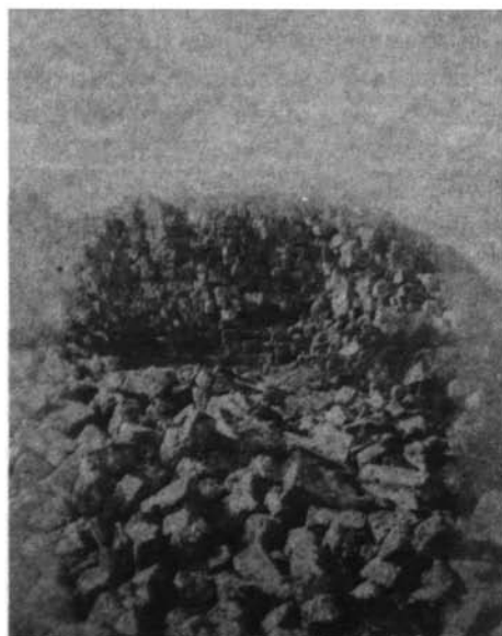
Fig. 3: Tombeau de la Chrétienne. Face est, l'éboulis après les fouilles de janvier 1856 (inédit). Photographie de J. B. Greene (n° 6), Bibliothèque de l'Institut de France, © Bachelier.
