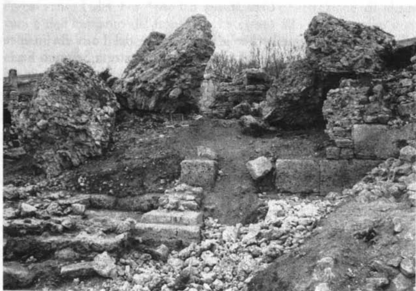
Monteleone Roccadoria, una fase dello scavo del Palazzo. Si notano i crolli di un ambiente voltato ed i muri perimetrali in conci tagliati di grandi dimensioni.
