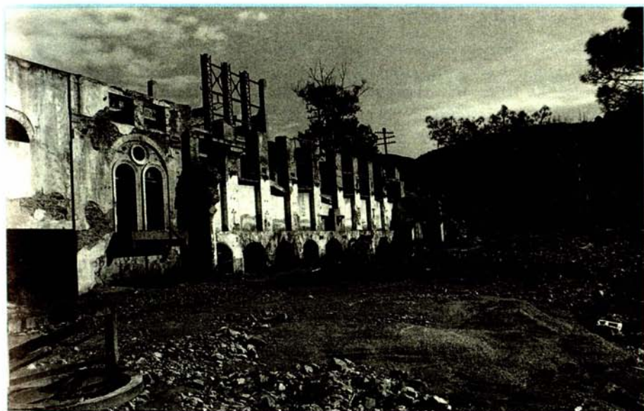
Fig. 6 Impianti abbandonati a Naracàuli, nell'Iglesiente.
