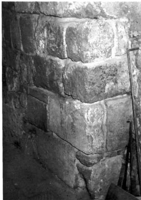
Fig. 28 - Nora. Santuario di Sant'Efisio: braccio Est dell'ambiente ipogeo, particolare della tamponatura.
