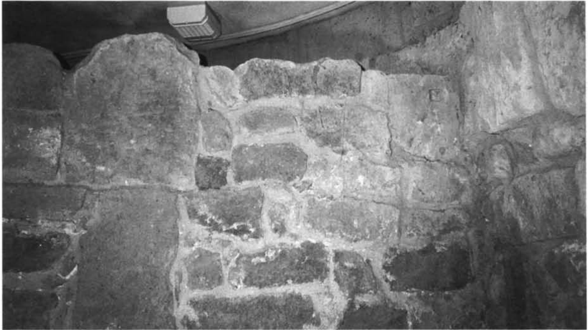
Fig. 49 - Fordongianus. Santuario di San Lussorio: muro in opera a telaio relativo al lato Nord dell'aula di VI secolo, visibile all'interno della cripta.
