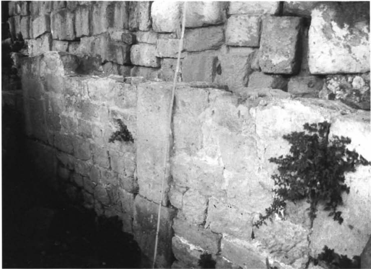
Fig. 48 - Fordongianus. Santuario di San Lussorio: muro in opera a telaio relativo al lato Sud dell'aula di VI secolo, oggi visibile all'esterno della cripta.
