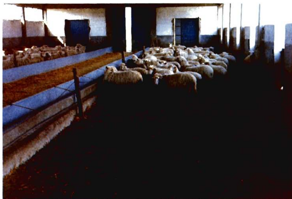
Foto 1-2 Edifici per ovini da latte con soluzione a lettiera permanente, di tipo semiaperto con recinti in doppia fila e corsia centrale di alimentazione. La struttura portante è in un caso in CA a campata unica. Le mangiatoie sono in elementi di lamiera.
