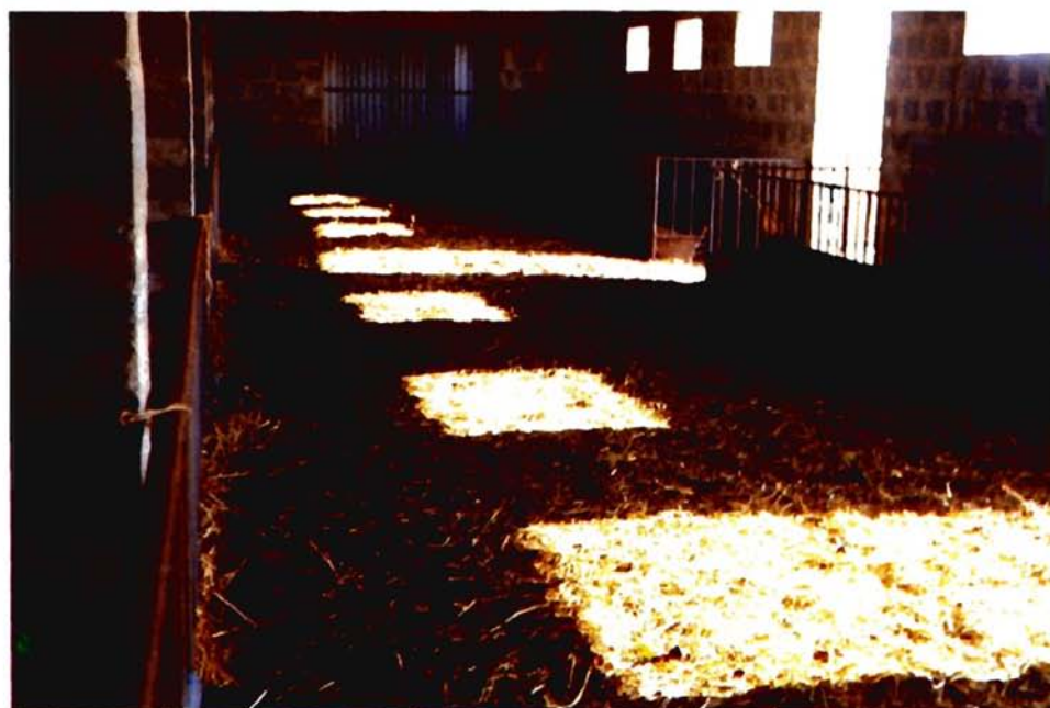
Foto 3-4 Edifici per ovini con strutture in muratura tradizionale e sostegni intermedi Construction for dairy sheep.
