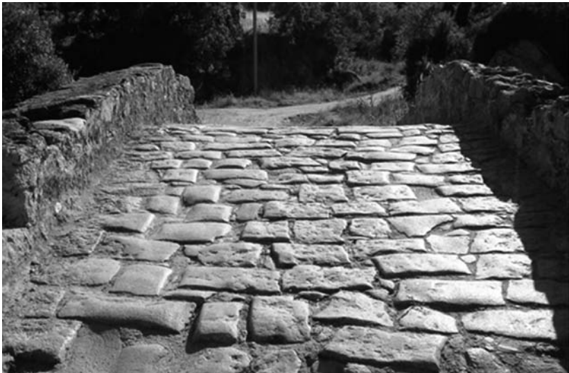
Fig. 5: Oliena, località Papalope, particolare della pavimentazione del ponte (foto G. Maisola).
