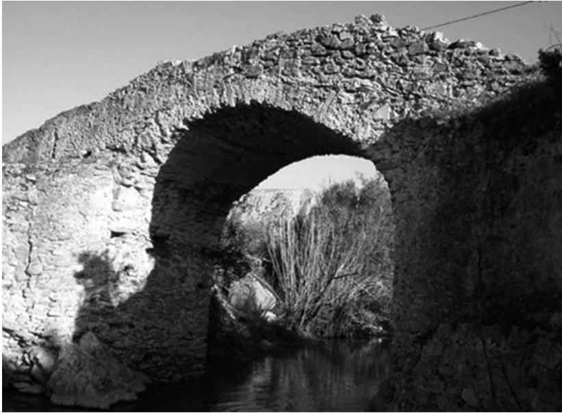
Fig. 4: Oliena, località Papalope, ponte ad arcata unica, visto da nord-ovest (foto G. Maisola).
