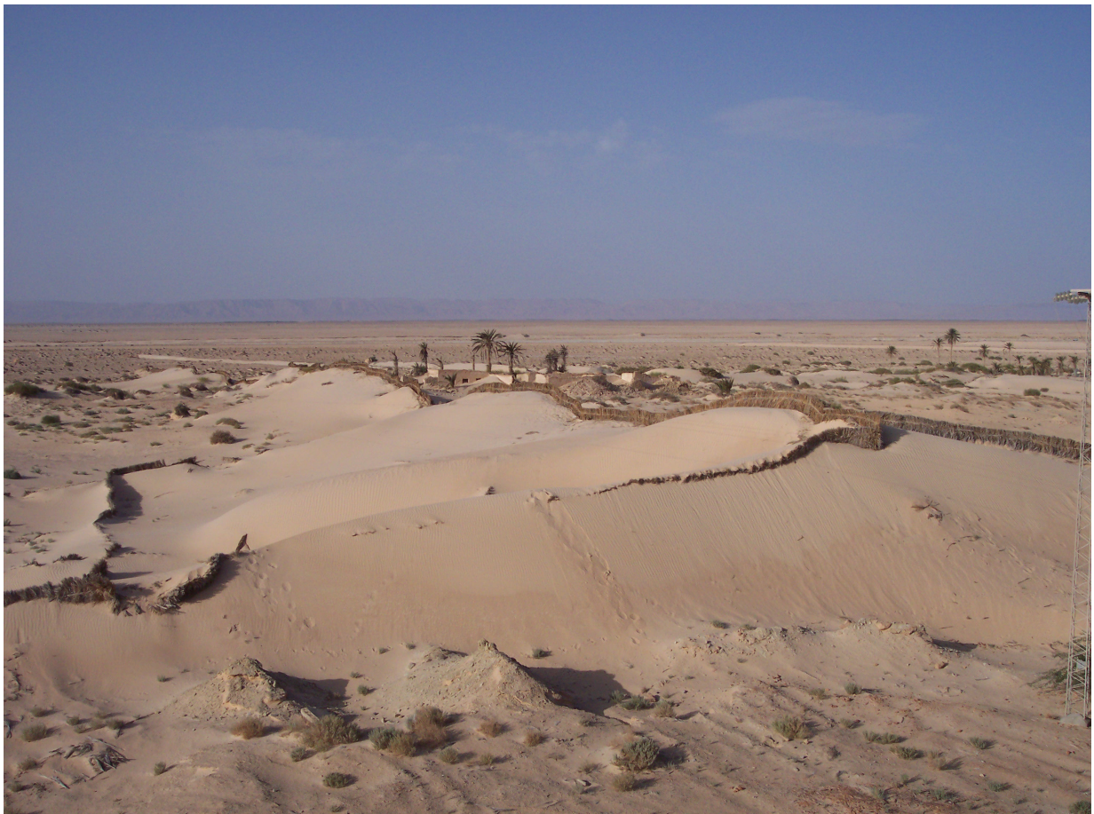
Figura 36. La fissazione delle dune mediante stuoie di foglie di palma ha permesso di evitare il seppellimento di un villaggio (foto T. Cugia)
