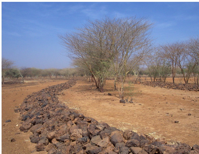
Figura 54. Argini in terra compattata e pietrame: funzione antierosiva e di trattenuta delle acque (foto T. Cugia)
