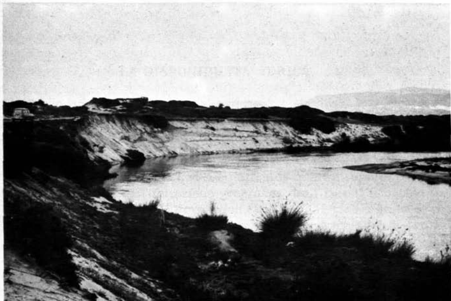
L'erosione fluviale del Coghinas lungo la parte esterna di un meandro situato in prossimità della foce sta scalzando il terreno di fondazione di una strada panoramica.
