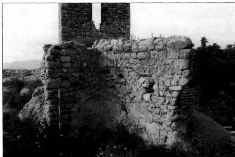
Fig. 8. Resti della cisterna soprastante al grande edificio rettangolare (indicato con S).
