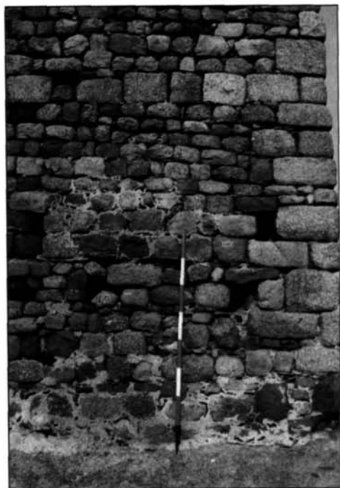
Fig. 11. Mastio. Particolare della tecnica muraria. In basso riconoscibili le tracce dell'intonaco originario.
