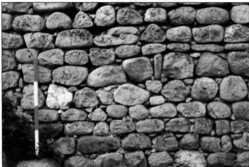
Fig. 10. Edificio con volte a crociera: particolare della tecnica muraria.
