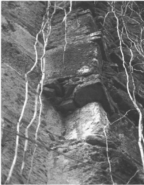
Fig. 50 - Oristano. Chiesa dello Spirito Santo: particolare delle murature esterne presso l'abside. È evidente l'ammorsatura di un braccio non più esistente.
