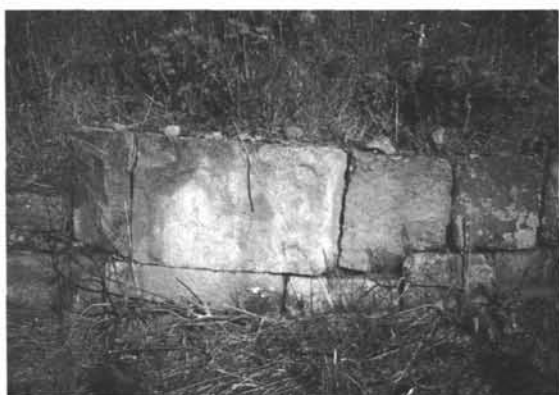
Fig. 176 - Ales. Castello di Barumele: particolare del muro in blocchi bugnati.
