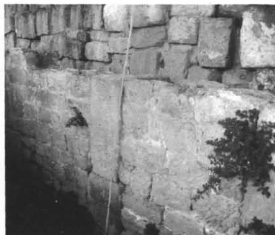
Fig. 57 - Fordongianus. Santuario di San Lussorio: muro in opera a telaio relativo al lato sud dell'aula di VI secolo.
