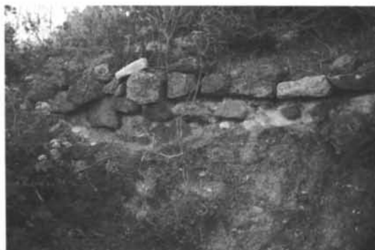
Fig. 106 - Cornus. Colle di Corchinas: tratti del circuito murario in opera a telaio.
