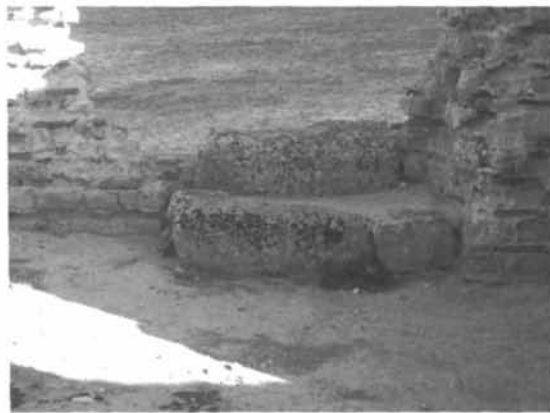
Fig. 81 - Tharros. Terme di Convento Vecchio: apertura tamponata.
