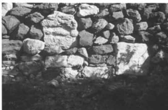
Fig. 105 - Cornus. Colle di Corchinas: tratti del circuito murario in opera a telaio.
