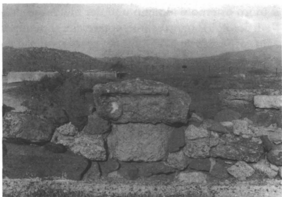
Fig. 20 - Nora. Ambienti presso il tempio di Eshmun: capitello ionico reimpiegato nelle murature in opera a telaio (da GIANNATTASIO 1994).
