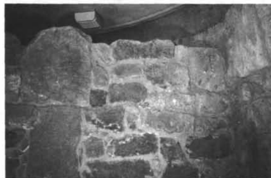
Fig. 58 - Fordongianus. Santuario di San Lussorio: muro in opera a telaio relativo al lato nord dell'aula di VI secolo.
