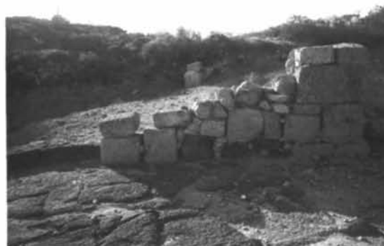
Fig. 86 - Tharros. Strutture che occupano in parte gli assi viari.
