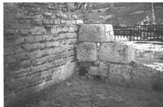
Fig. 82 - Tharros. Terme di Convento Vecchio: strutture in grossi blocchi impostate sul pavimento dell' apodyterium .
