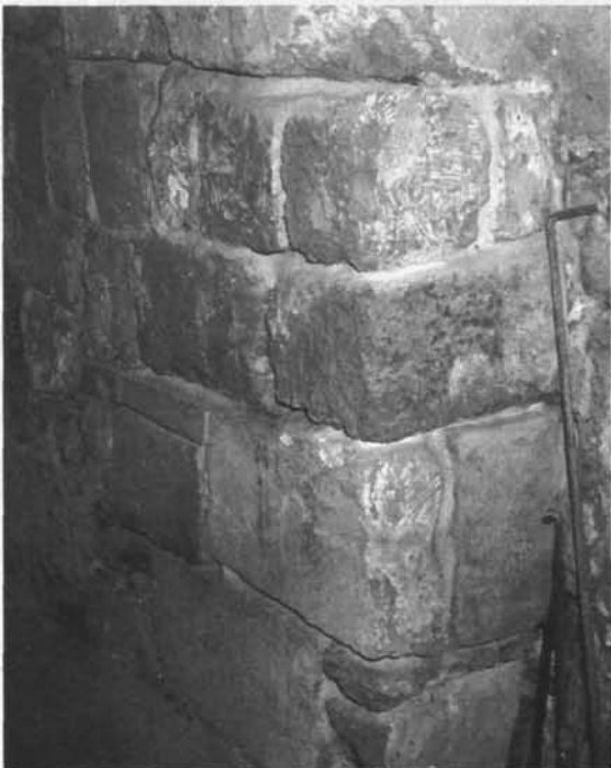
Fig. 31 - Nora. Sant'Efisio: particolare della tamponatura.
