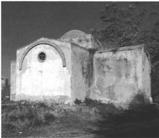
Fig. 161 - Simaxis. San Teodoro di Congius: veduta esterna.
