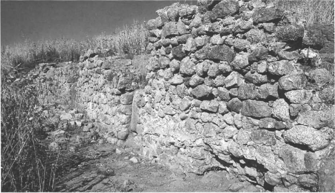
Fig. 180 - Oschiri. Castro: tratti del circuito murario a Sudest.
