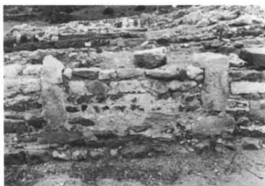
Fig. 110 - Cornus. Località Columbaris: particolare del muro di restringimento della navata nord della cattedrale, realizzato in opera a telaio (da PANI ERMINI 1986b).
