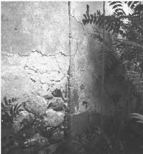
Fig. 51 - Oristano. Chiesa dello Spirito Santo: particolare delle murature esterne. Si nota una fase in blocchi squadrati a cui sembrano appoggiarsi murature in opera incerta.
