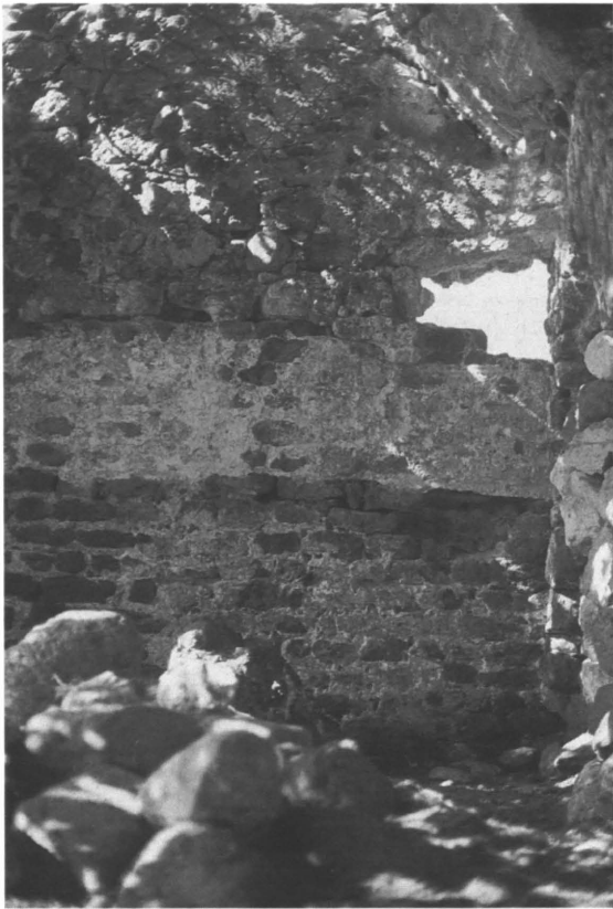
Fig. 144 - Narbolia. Sant'Andrea Pischinappiu: particolare delle murature.
