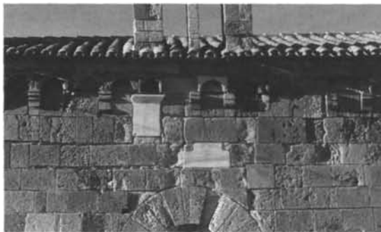
Fig. 60 - Fordongianus. San Lussorio: lato sud della chiesa romanica, con base dell'altare del santuario di VI secolo ed epigrafe del vescovo Elia, riutilizzate nella muratura.
