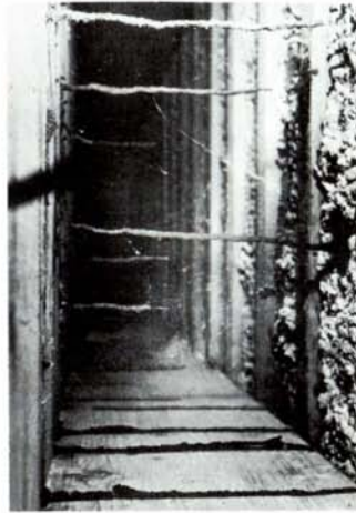
Fig. 4 - Travi di sostegno danneggiate da Reticulitermes lucifugus Rossi (a sinistra); Caratteristiche camminamenti costruiti da R. lucifugus (a destra).
