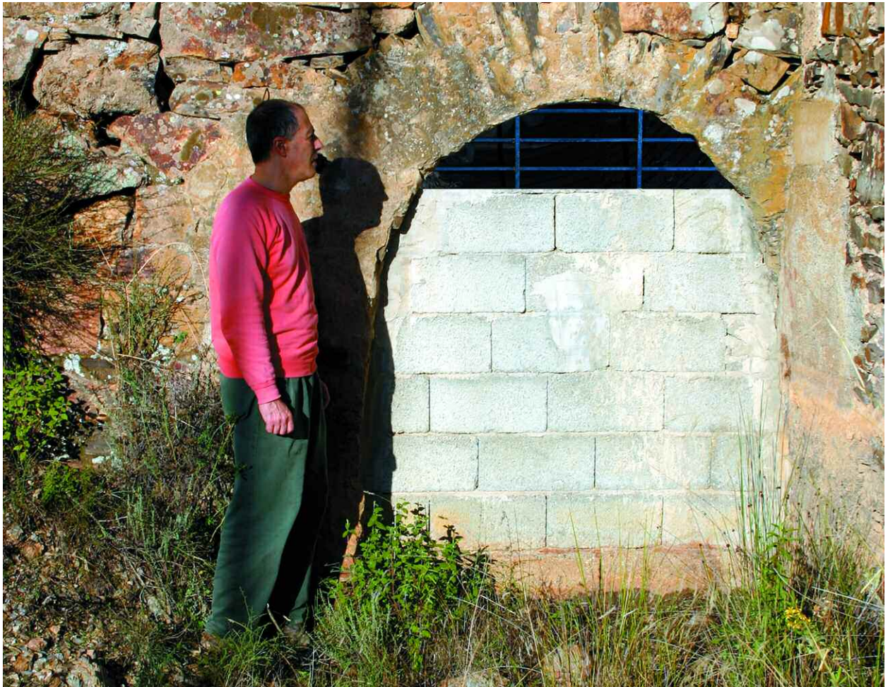
Fig. 8 - Sbarre orizzontali disposte sopra un muro.
