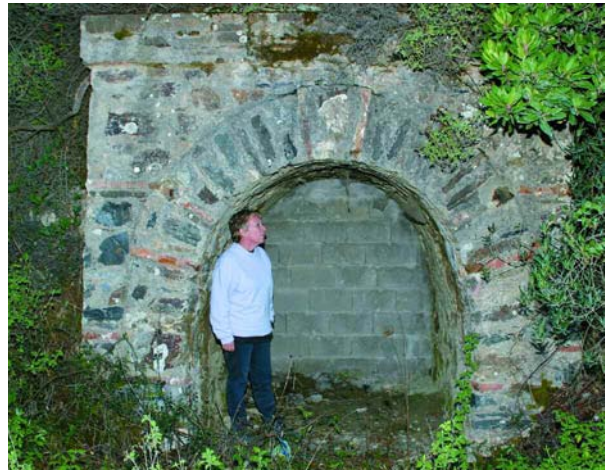
Fig. 6 - Galleria totalmente murata.
