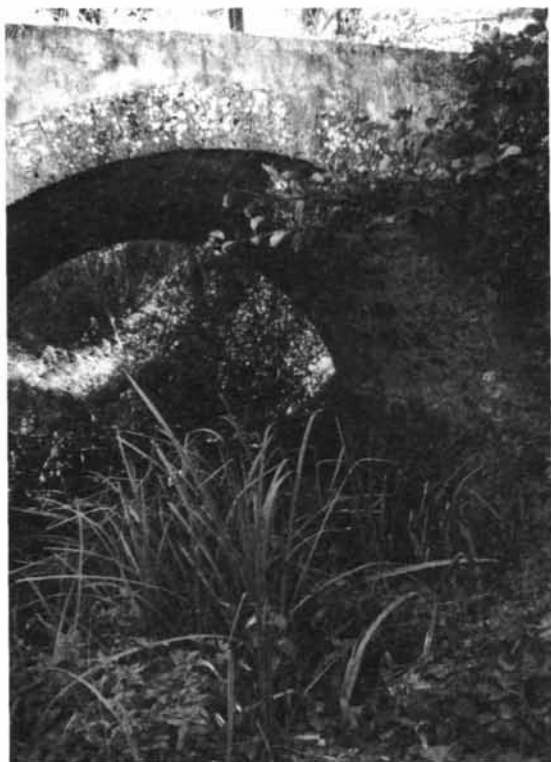
Foto 1-2 - Santulussurgiu. Il ponte sul Rio Cispiri.
