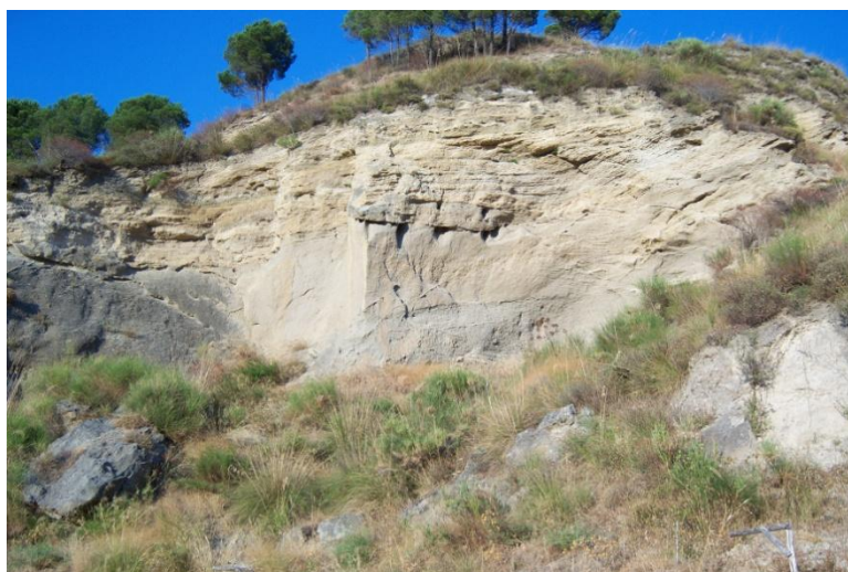
Figura 65: Località Soforio di Armo (Gallina, RC). Fronte di cava.
