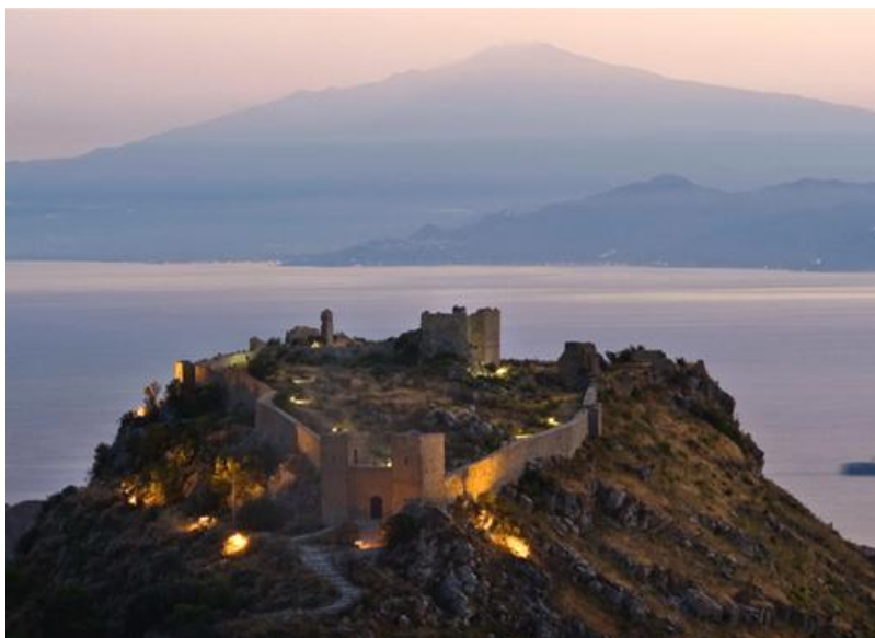
Figura 44: Veduta panoramica del castello San Niceto.
