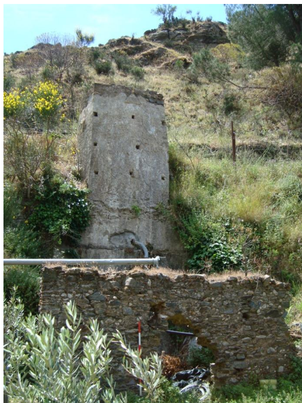
Figura 61: Mulino nel vallone Allai ristrutturato nel 1873.
