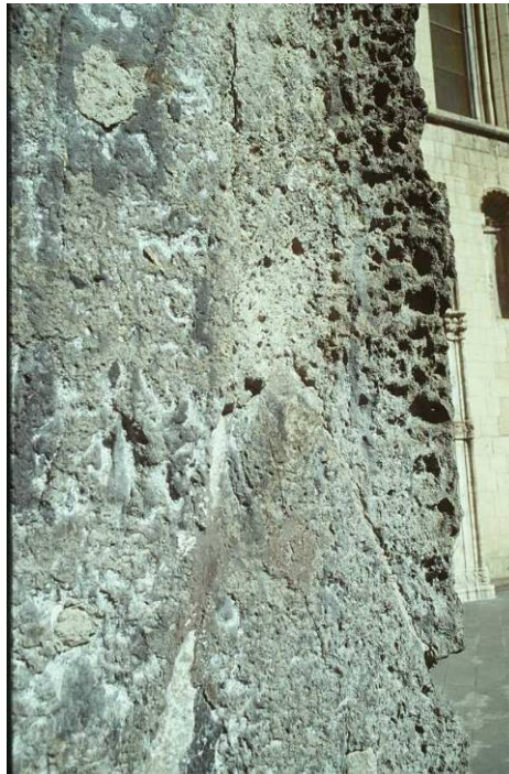
Fig. 3.5 - Napoli, Chiesa di S. Giovanni a Carbonara - Piperno: esempio di alveolizzazione.
