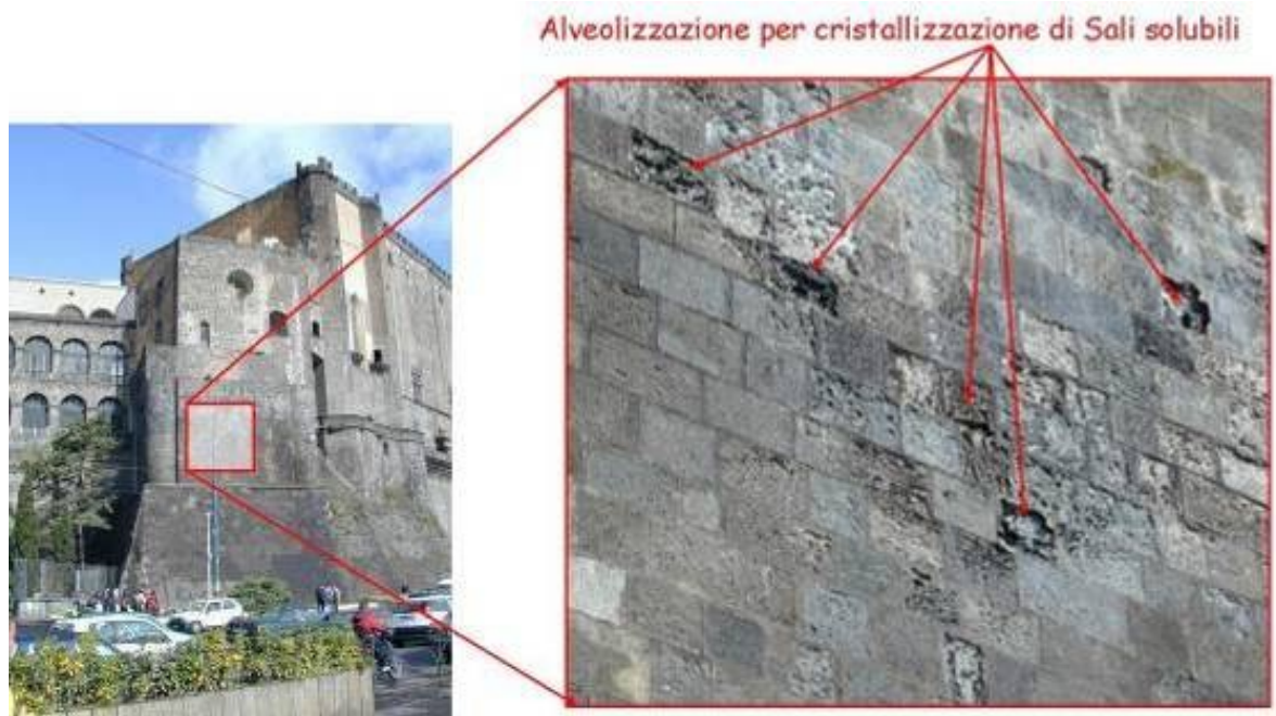
Fig. 3.10 - Napoli, Maschio Angioino - Facciata Est (lato mare): esempio di alveolizzazione per cristallizzazione di sali solubili.
