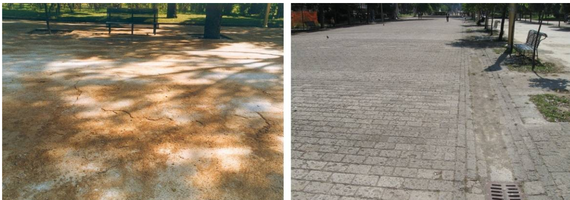
Fig. 2.10 - Villa Comunale, Napoli - Pavimentazione (a destra) e battuto (a sinistra) in IC gi .
