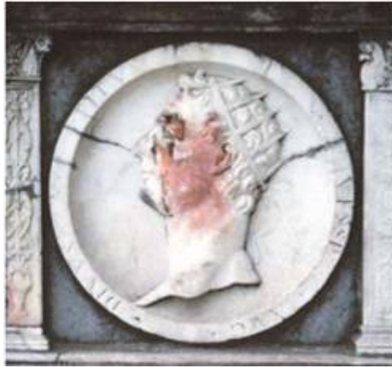
Fig. 3.7 - Pavia, Certosa di Pavia, Marmo - Alterazione cromatica: l'originario colore bianco del marmo si è modificato in un colore rosso tenue, a causa dei processi di ossidazione superficiale.
