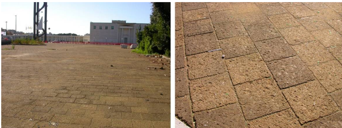
Fig. 2.17 - Piazzale Tecchio, Napoli - Pavimentazione realizzata con blocchetti di TGN.
