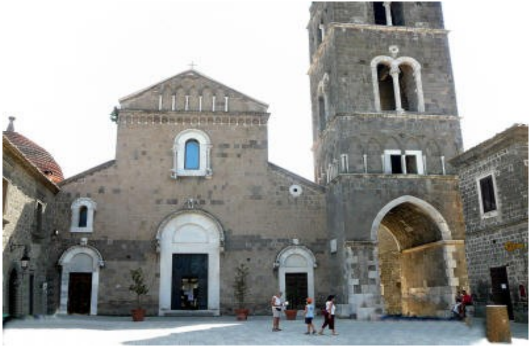
Fig. 2.5 - Cattedrale di Casertavecchia (CE) - esempio di utilizzo in IC gr .
