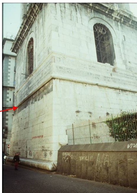
Fig. 3.8 - Napoli, Campanile di S. Chiara: esempio di crosta nera in ambiente urbano.
