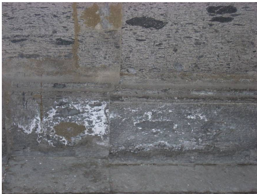
Fig. 3.1 - Napoli, Cortile delle Statue palazzo del Salvatore Università Federico II: esempio di efflorescenza su colonne di \text{IC}_{gr} .
