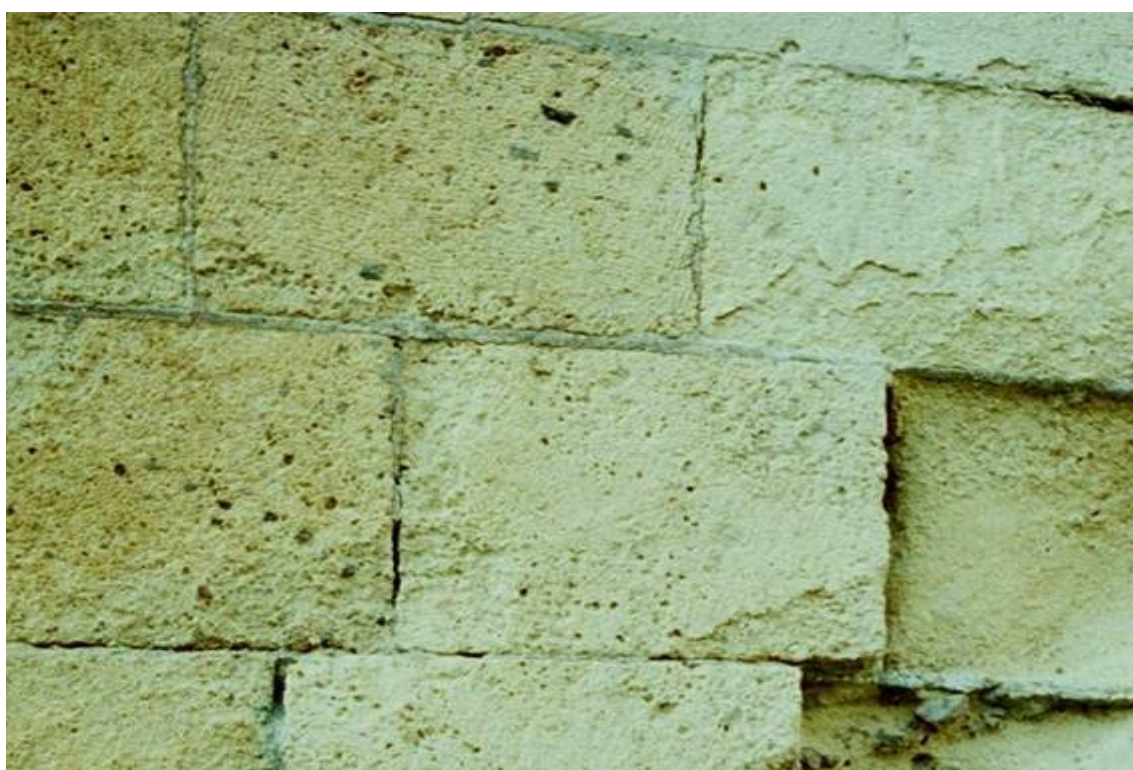
Fig. 3.13 - Basilica di S.Chiera, Napoli - TGN: esempio di esfoliazione e conseguente arretramento concavo-parallelo.
