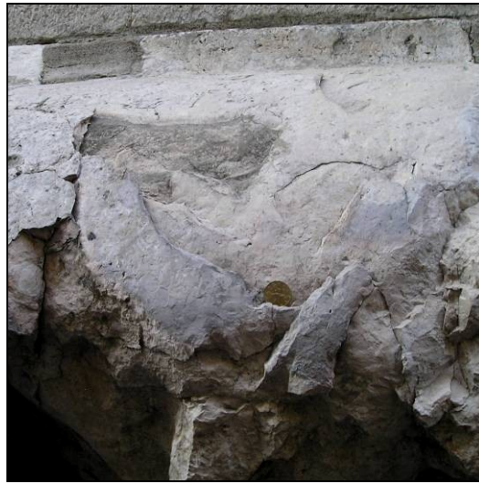
Fig. 3.4 - Napoli, Campanile di S.Chiera: esempio di scagliatura.
