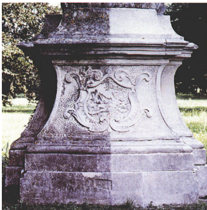
Figura 3.2 – Rimozione di alghe e licheni dal basamento (foto Esedra da Scannerini & V.Heuvel, 1997).
