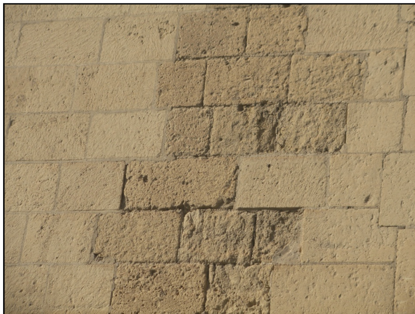
Figura 2.13 – Alveolizzazione in conci di TGN della facciata principale della Basilica di S.Chiera (Napoli).
