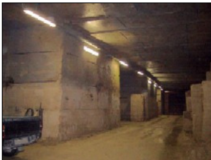
Figura 4.4 – Cava in galleria della PV, Nanto (VI).
