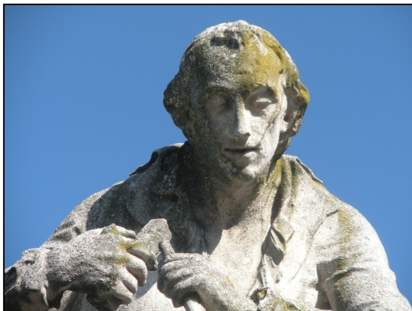
Figura 2.18 – Alterazione biologica e crosta nera su una statua in PV di Prato della Valle, Isola Memmia (Padova), in alto, e particolare dell'area interessata da colonizzazione biologica, in basso.
