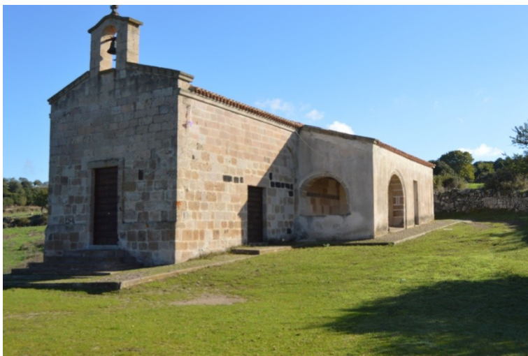
Fig. 7.75. Querqueto (Ittireddu): UT SGQ 1 vista da sud- ovest.
