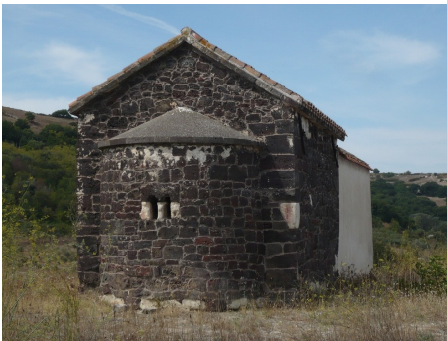
Fig. 7.35. S. Andrea di Torralba, vista da est, si possono notare la bifora nell'abside e l'allungamento verso ovest.
