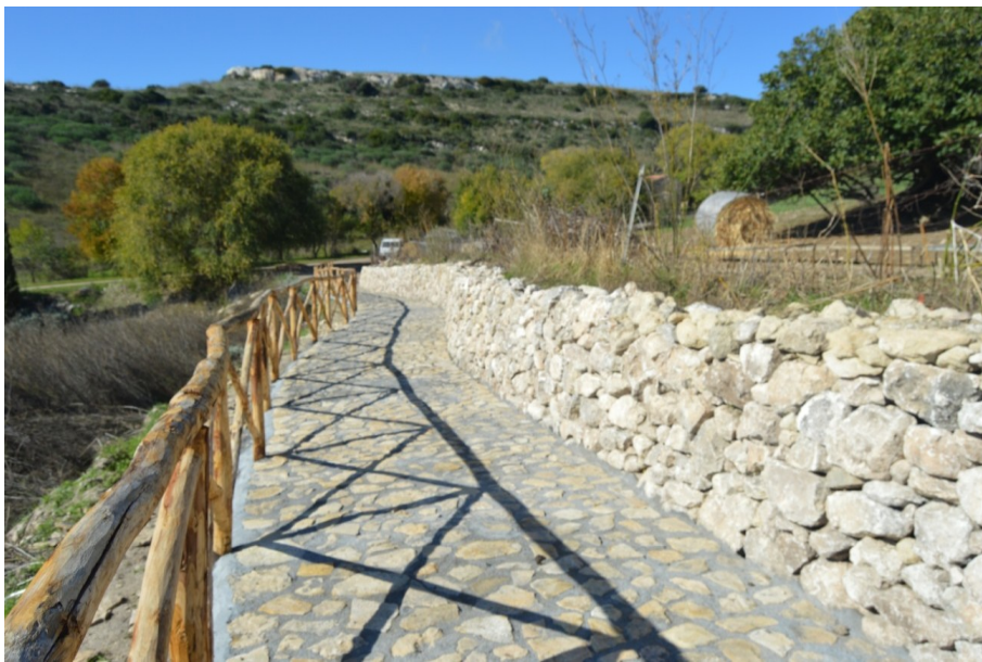
Fig. 7.57. Lachesos (Mores). La strada della sezione esposta dell'immagine precedente dopo la pavimentazione e le opere.
