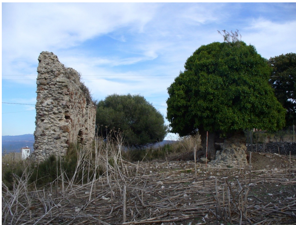
Fig. 30. Hostiano de Monte. Ruederi della chiesa di San Giuliano.
