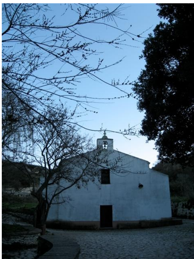
Figg. 21-22. Santa Giusta de Sas Abbas. Facciata.
