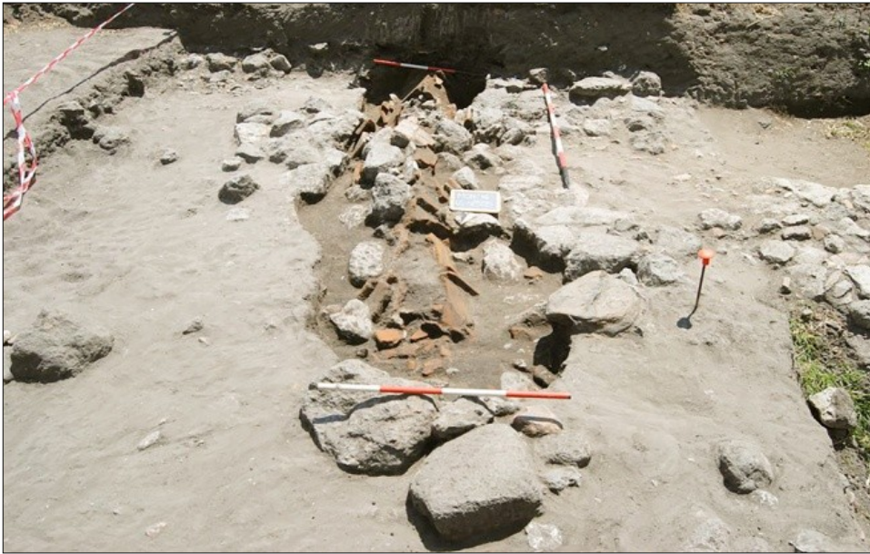
Fig. 50. Mesumundu, Area 2500, canaletta realizzata in embrici di riuso probabilmente per il drenaggio delle acque meteoriche, databile postquem al X secolo.
