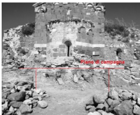
Fig. 7. Orria Pithinna. Interventi di risanamento e di consolidamento del 1976. Si noti lo sterro in prossimità dell'abside stimato (in quanto la foto non ha alcun riferimento metrico) a circa 50 cm (forse più) al di sotto del pian di campagna. (rielaborazione di Casula 2012, p. 119, fig. 13).
