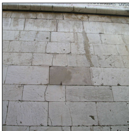
Figura 6.2 - Tipologie di degrado riconosciute sul basamento della Torre Campanaria del Complesso Monumentale di Santa Chiara: a) mancanza e crosta (facciata sud); b) efflorescenza (facciata ovest); c) esfoliazione (facciata ovest); d) integrazione, incrostazione, efflorescenza, crosta, fratturazione (facciata nord).
