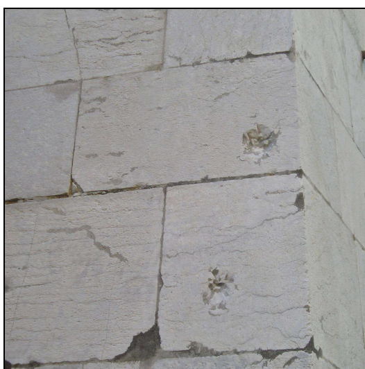
Figura 6.2 - Tipologie di degrado riconosciute sul basamento della Torre Campanaria del Complesso Monumentale di Santa Chiara: a) mancanza e crosta (facciata sud); b) efflorescenza (facciata ovest); c) esfoliazione (facciata ovest); d) integrazione, incrostazione, efflorescenza, crosta, fratturazione (facciata nord).
