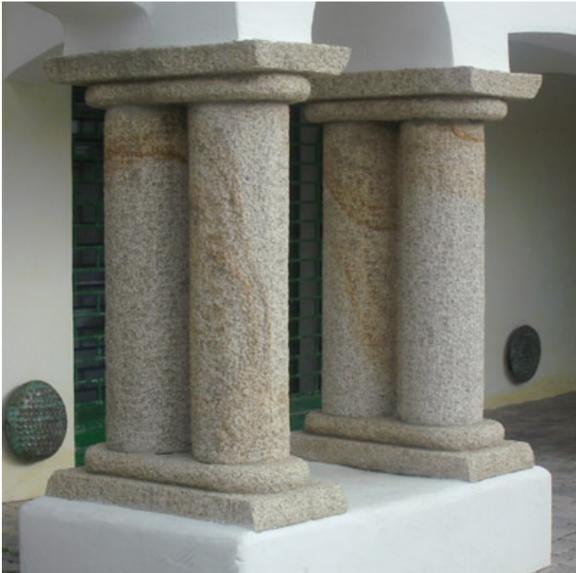
Figura 5-2 Colonne realizzate in granito Giallo San Giacomo.
