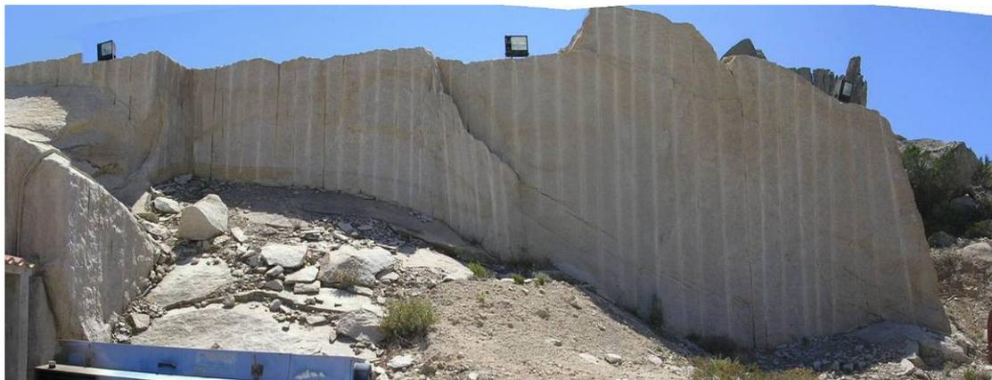
**Figura 6-10** Diffusione degli ossidi di ferro in un fronte.
