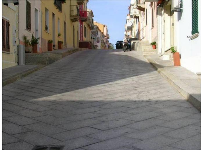
**Figura 3-5 Esempio di lastricatura stradale (Santa Teresa di Gallura).**
