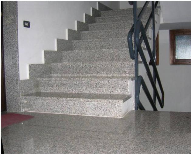
**Figura 3-2** Pavimentazione e rivestimenti interni realizzati interamente in granito.
