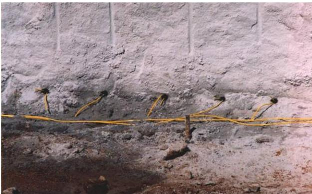
**Figura 3-28** Miccia detonante nei fori.
