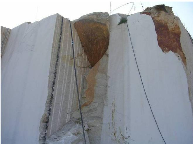
**Figura 6-25 Fratture riempite da ossidi e idrossidi di ferro.**
