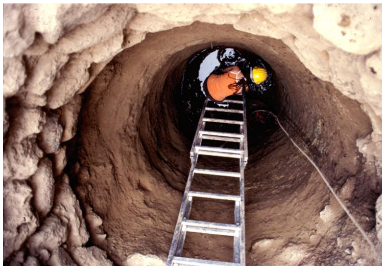
Fig. 8 Una fase di scavo all'interno del pozzo (immagine M.Milanese)
