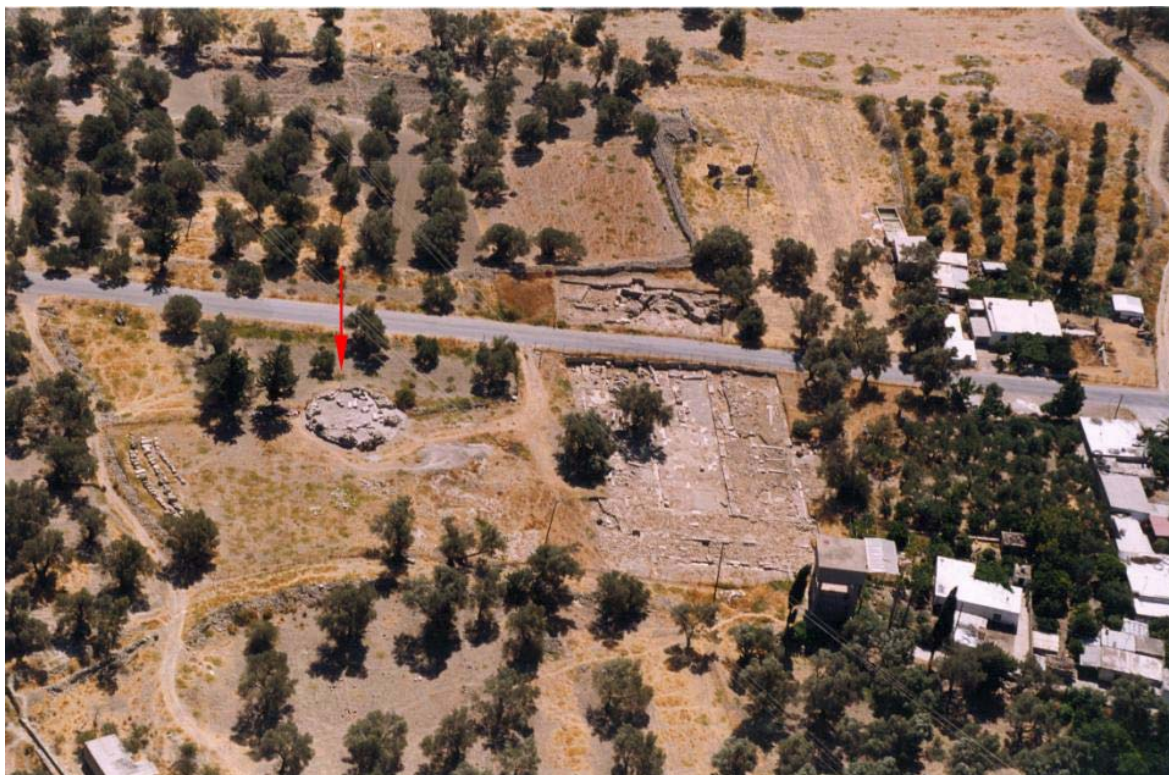
FIGURA 6.2.14. veduta aerea del complesso della Basilica di Mitropolis; la freccia rossa indica il Battistero (da Ricciardi 2009).
