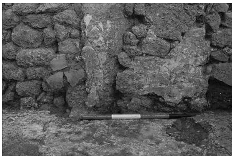
Fig. 30 – Il muro occidentale dell'ambiente Ce.
