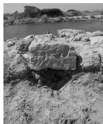
FIG. 16 CANALE DI SCOLO DELLE ACQUE DELLA VASCA
