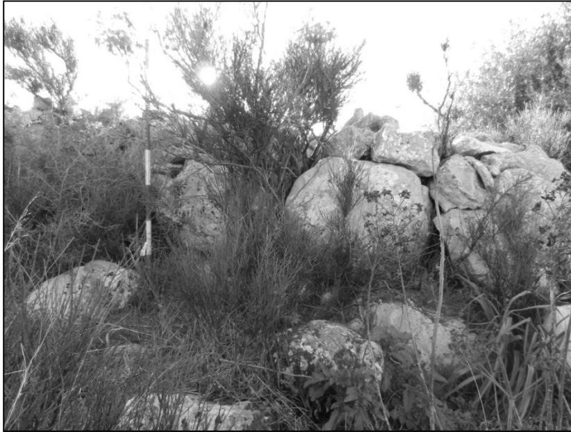
Tav. 28. Ossi. Particolare della muratura Nord del nuraghe Monte Aranzu; sotto: particolare costruttivo di un paramento murario
