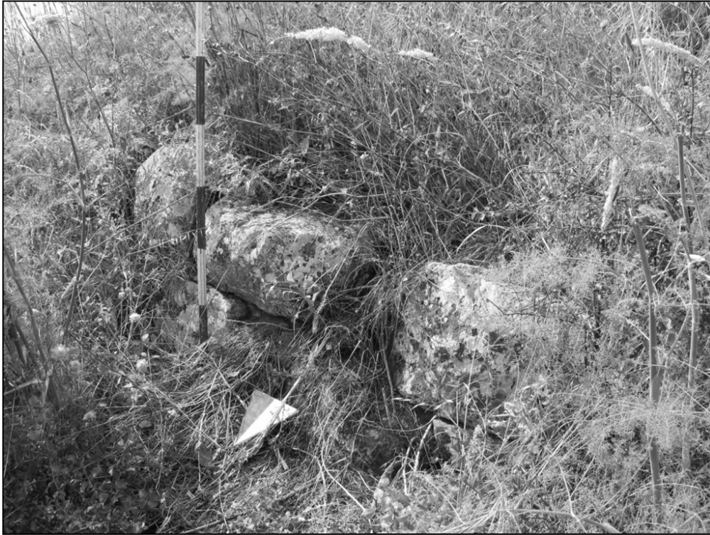
Tav. 36. Ittiri. Resti delle murature Nord del nuraghe Sa Punta 'e Sa Nansa
