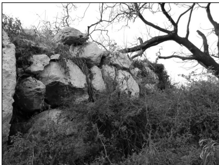
Tav. 103. Florinas. Particolare della muratura del nuraghe Giaga 'e Puliga; sotto: rilievo roccioso in cui si imposta l'edificio
