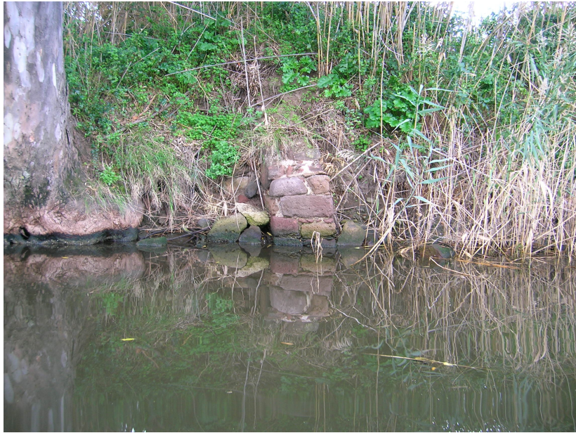
Figura 8 - prospezione del 9 dicembre 2011 – sito A, lacerto di muro.
