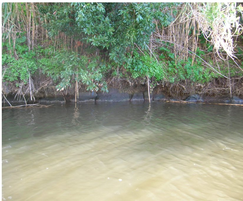
Figura 10 - prospezione del 9 dicembre 2011 – sito D, blocchi di basalto a costituire una probabile banchina di ormeggio per il carico e scarico dei materiali.
