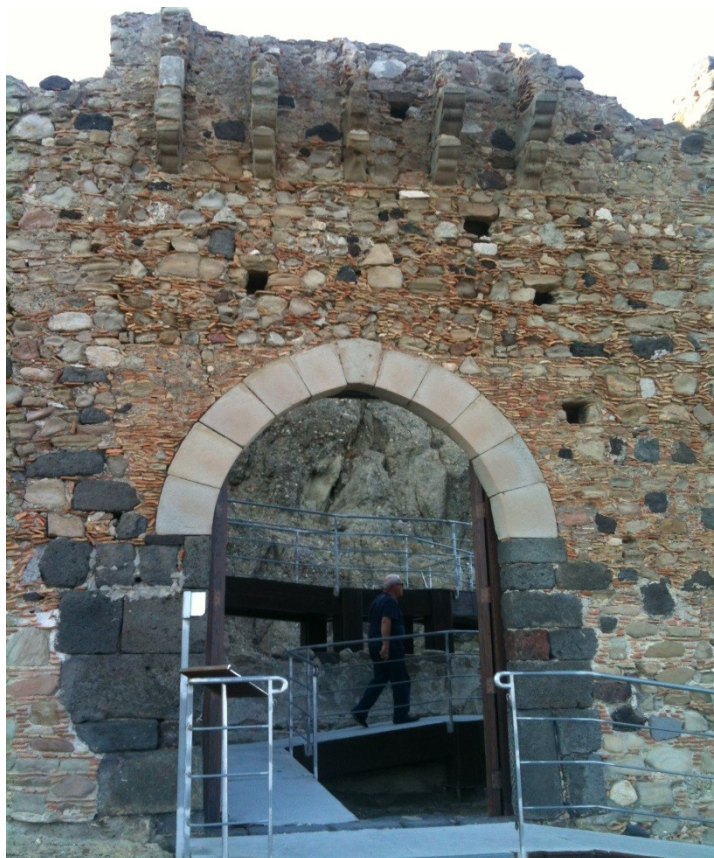
Fig 3 Porta d'ingresso con arco a sesto acuto
