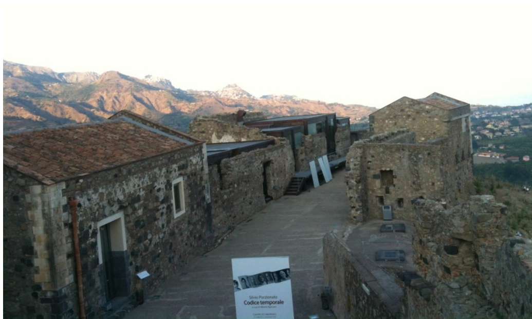
Fig. 4 Il cortile del castello dopo il restauro; sullo sfondo Taormina e Castelmola
