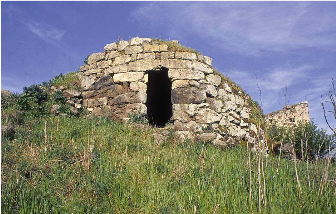
Nuraghe Ponte. Particolare del restauro.
