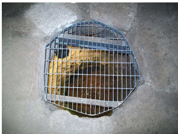
Fig. 47. Il nuovo pozzo scoperto nel corridoio anulare.
