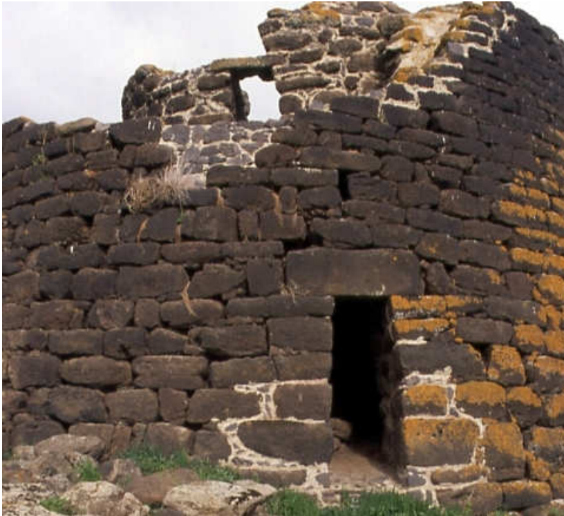
Nuraghe Oes. Il finestrone del primo piano.
