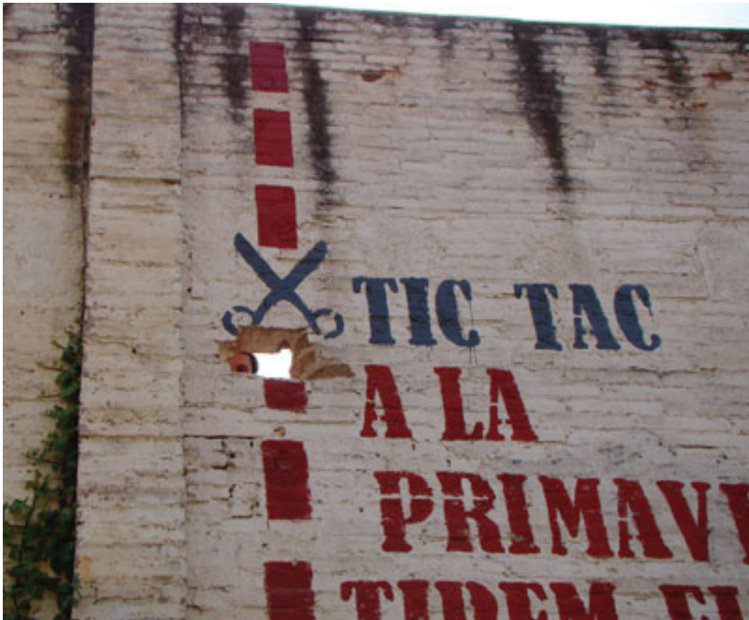
Foto 1 Demolizione del muro 26/03/2013 (fonte E13 2013a)
