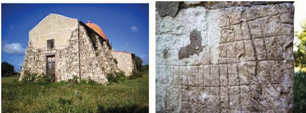
FIGURA 30: VEDUTA DELLA CHIESETTA DI SANT'ANTONIO DA PADOVA E L'IMMAGINE DEL CONCIO A RETE.
