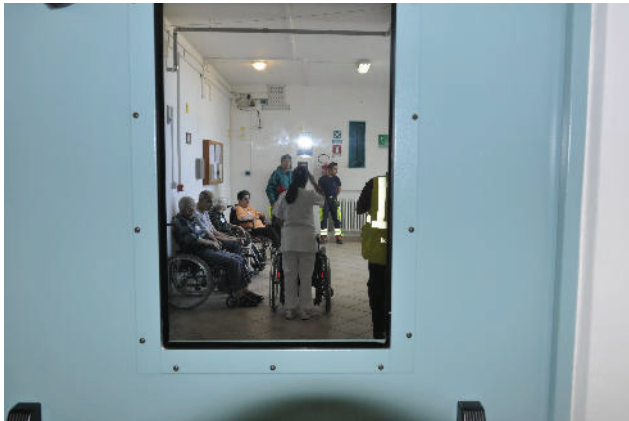
Figura 4.9. Porta REI con vetro per aumentare l'Accesso visivo alle scale. Purtroppo solo alcune porte presentano questa caratteristica
