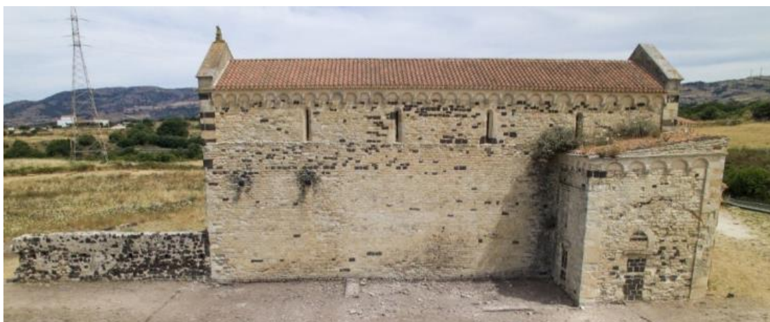
Fig. 74b. Ripresa aerea del lato meridionale della chiesa (foto G. Saturno).
