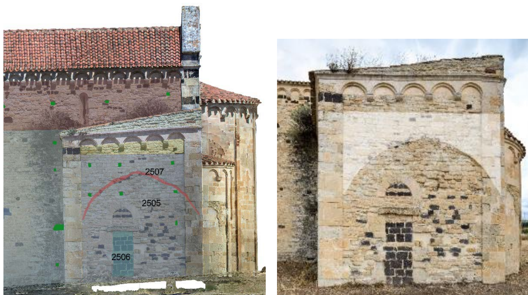
Fig. 78. L'esterno meridionale del transetto: in evidenza (a destra) l'attacco della volta a botte
