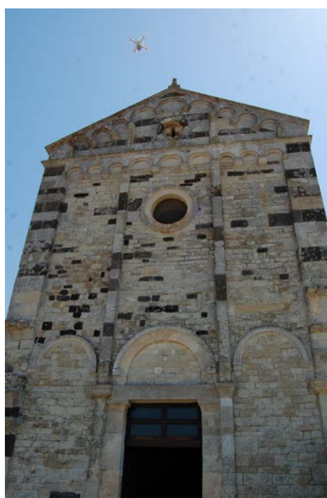
Fig. 66. La facciata di San Michele durante le riprese col drone.
