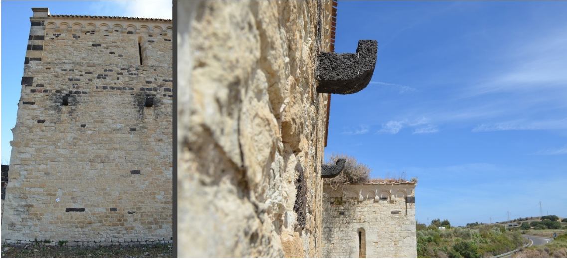
Fig. 75. Le mensole a gancio nel lato meridionale dell'edificio.
