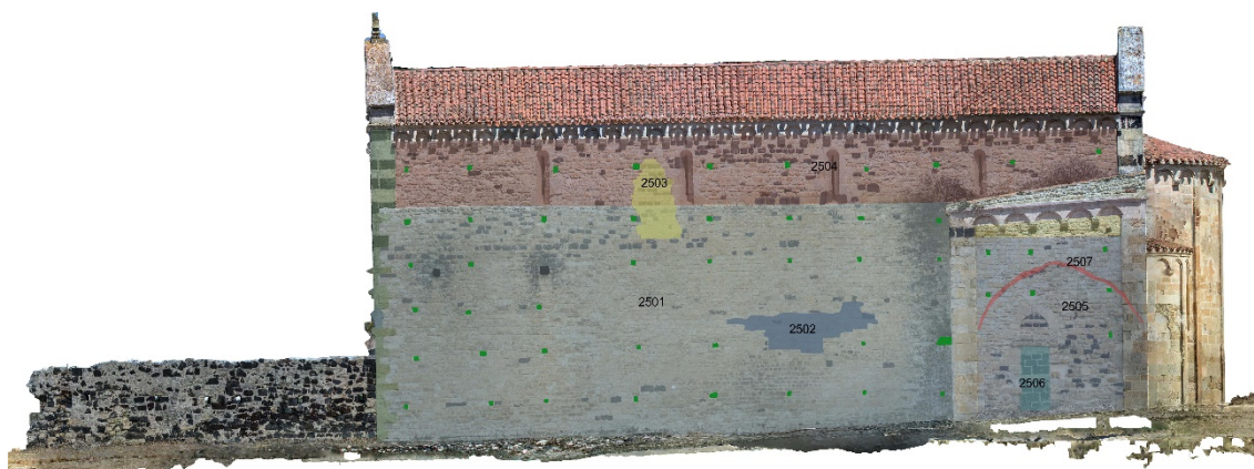
Fig. 101. L'analisi stratigrafica muraria del settore meridionale della chiesa.
