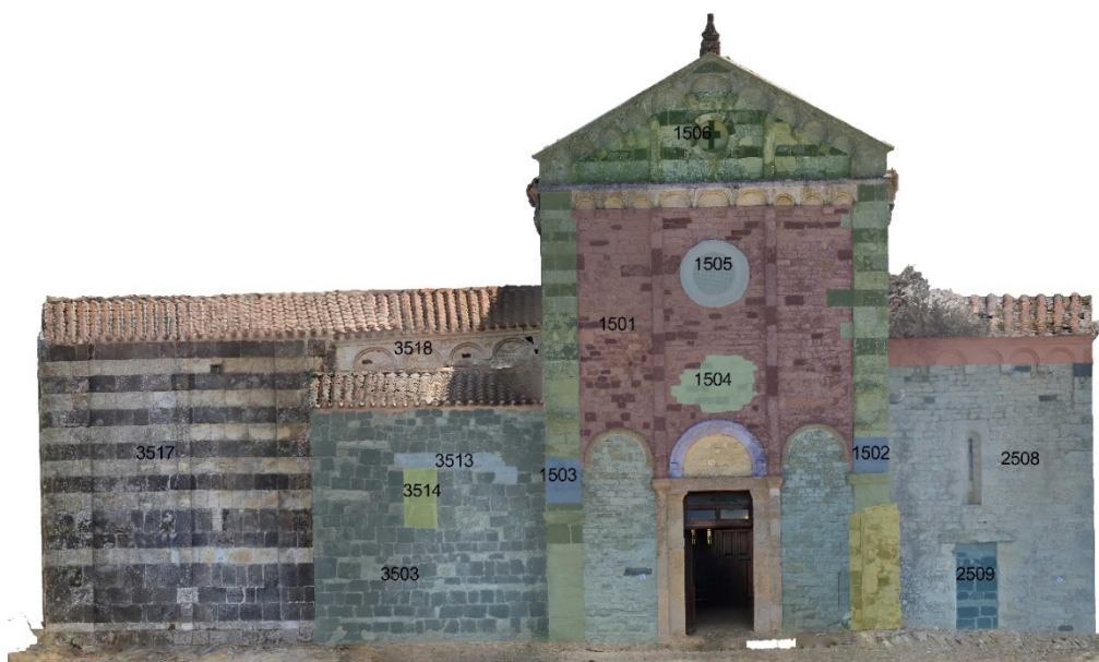
Fig. 100. L'analisi stratigrafica muraria del settore occidentale della chiesa.
