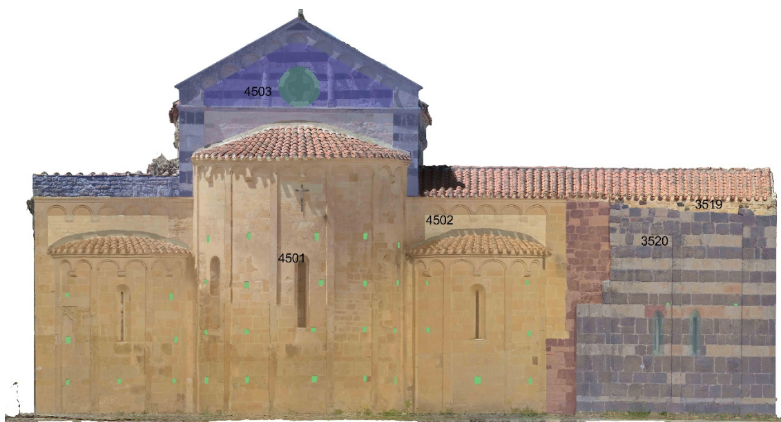
Fig. 102. L'analisi stratigrafica muraria del settore orientale della chiesa.
