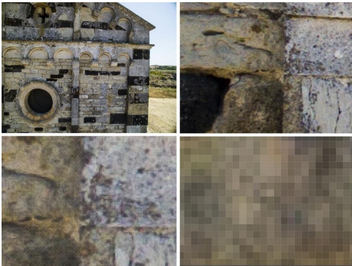
Fig. 21. Un'immagine della chiesa di San Michele di Salvennor con quattro differenti livelli d'ingrandimento. Nell'ultimo, in basso a destra, si vedono chiaramente i pixel che compongono l'immagine.
