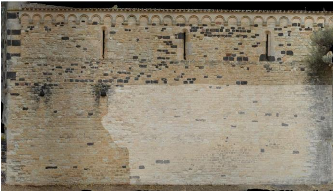
Fig. 73. Prospetto meridionale: in bianco la superficie muraria restaurata nel 1912.
