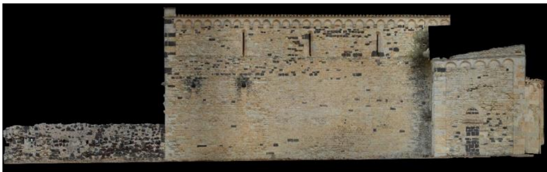
Fig. 74a. Fotopiano del lato meridionale della chiesa ricavato dal modello fotogrammetrico da terra.
