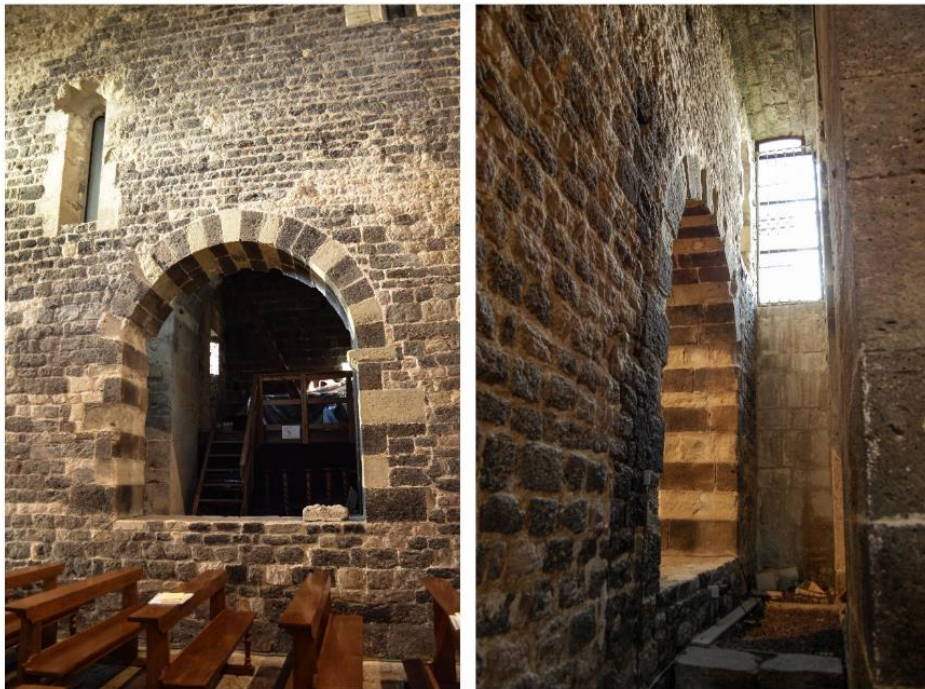
Figg. 84 - 85. Chiesa di Saccargia. L'apertura che mette in collegamento la chiesa e il campanile.
