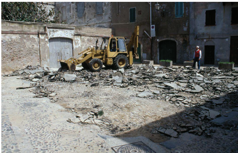
Figura 14: Alghero, piazza Santa Croce. maggio 1997. Asportazione del manto d'asfalto con mezzo meccanico.
