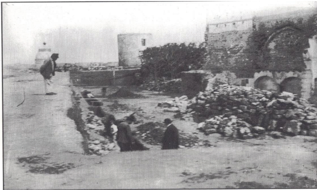
Figura 17: foto d'epoca (1910, da VALSECCHI 1996) che mostra l'abbattimento della chiesa di Santa Croce (a destra) e il probabile scavo delle fondazioni dell'Ospedale Civile (sulla sinistra). La muratura visibile nella parte destra potrebbe appartenere al perimetrale individuato dallo scavo. Gli alberi in secondo piano fanno forse parte del cortile del Monastero delle Isabelline. Sempre sulla sinistra si nota un accumulo di conci squadrati, probabilmente risultato dello smantellamento della chiesa.
