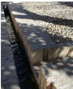
Fig.2.78 In basso, Sistema di raccolta dell'acqua nel patio della grande moschea di Cordoba. (Spagna).
