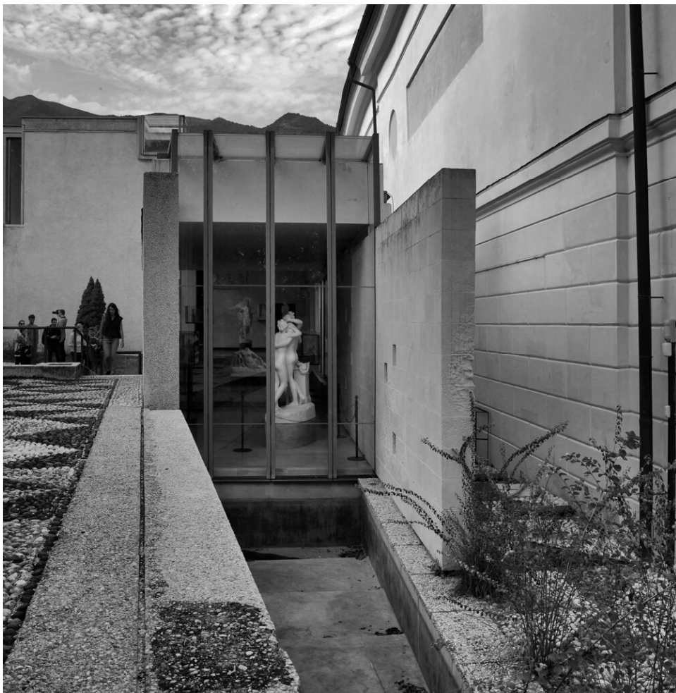
Fig.2. 108 Carlo Scarpa, Gipsoteca Canoviana , particolare del muro e della vasca priva di acqua, Posagno, (Italia), (1955 - 1957).
