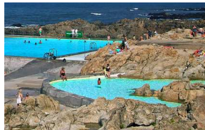
Fig.1.36 Alvaro Siza, Piscinas Das Marés , la forma curva un riferimento alla costruzione delle dighe nella vasca più piccola delle, Leça da Palmeira, (Portogallo), (1961-1966).
