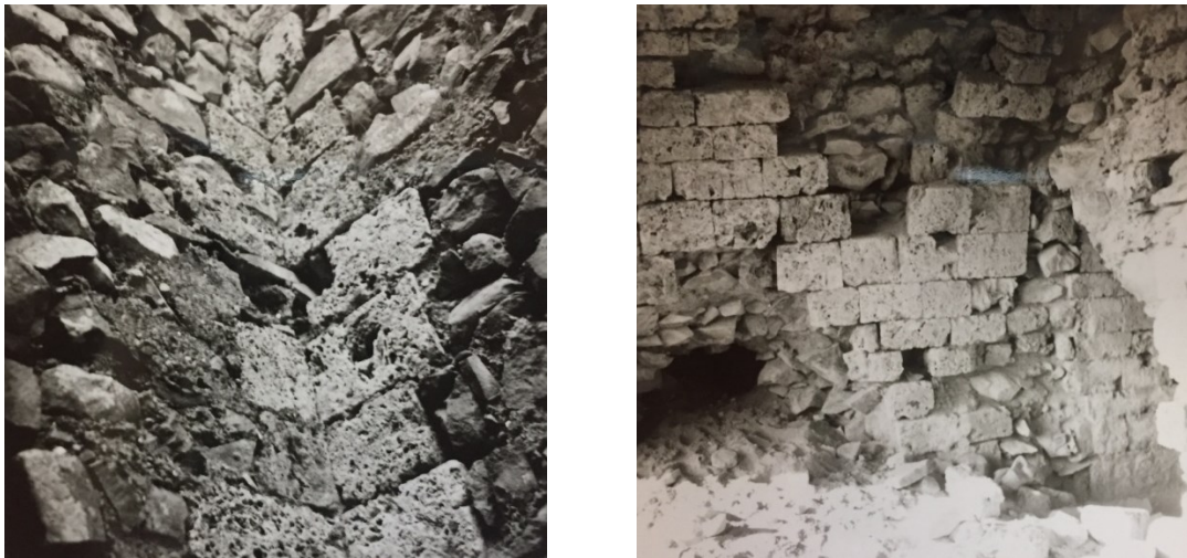
Figura 44-45: Nel castello di Gioiosaguardia gli spigoli della muratura sono realizzati con conci di natura calcarea perfettamente squadri e posti in opera con una struttura a dente, tale da incastrare i conci l'uno nell'altro. Questo permette di capire che i paramenti murari sono stati elevati nello stesso momento costruttivo (a sinistra; gli stessi conci squadri si ritrovano all'interno del vano della cisterna (a destra)). (ASBEAP_CA-OR)
