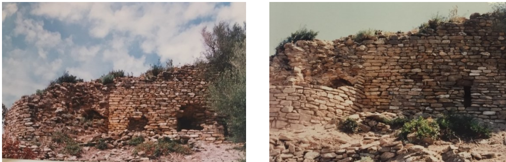
Figure 83-84: Foto che illustrano la situazione dopo il decespugliamento, pulitura e prima preparazione alla fase successiva con il puntellamento, la reintegrazione e il restauro secondo ricorsi e pontate (ASBEAP_CA-OR)
