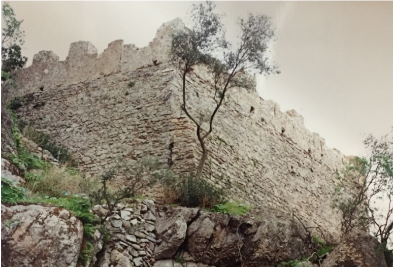
Figura 39: foto della torre cisterna del Castello di Acquafredda. La presenza di differenti tecniche costruttive se non trova ragione in convenienti soluzioni tecniche, può essere dovuta nella maggior parte dei casi a diversi periodi costruttivi.
