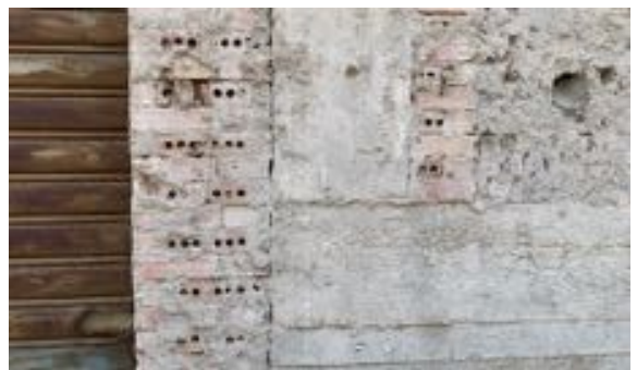
Blocchi di calcestruzzo, basamento in blocchi di trachite e mattoni in laterizio
