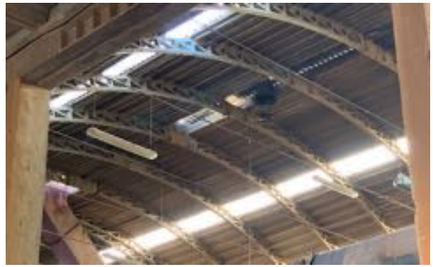
Archi reticolari con getto pieno in calcestruzzo armato
