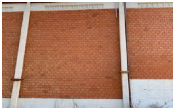
Pareti in mattoni di laterizio
