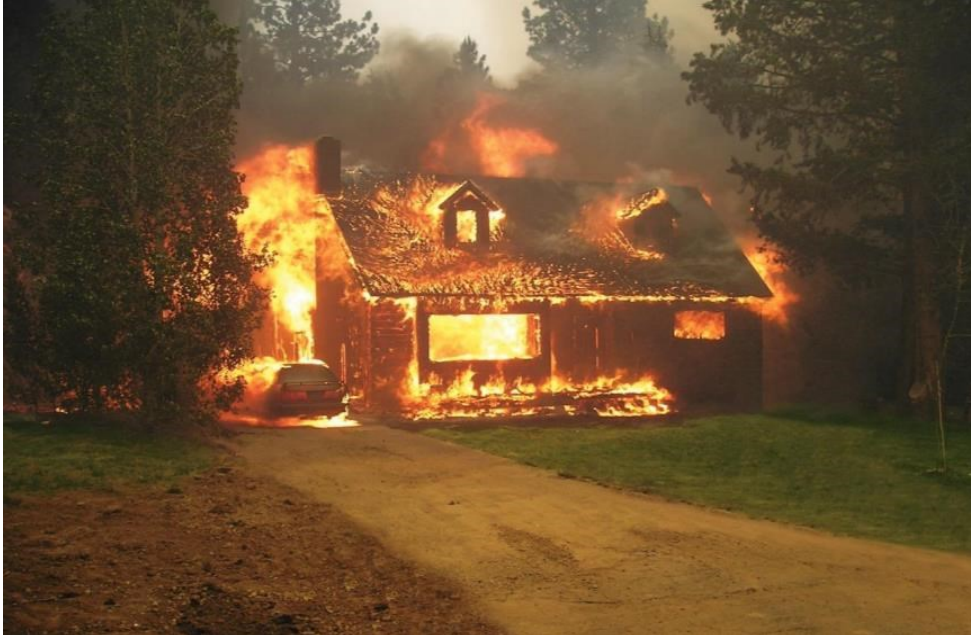
Figura 17. Le fiamme causate da un tizzone acceso trasportato dalla colonna di fumo di un incendio ancora lontano dall'abitazione, divampano e distruggono completamente una struttura costruita in materiale combustibile. Photo courtesy of the USDA Forest Service – LTBMU (USA)
