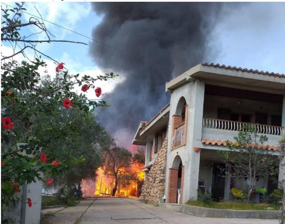
Figura 14. Le fiamme entrano in contatto diretto con la struttura durante un incendio nella zona centro orientale della Sardegna (fonte CFVA).
