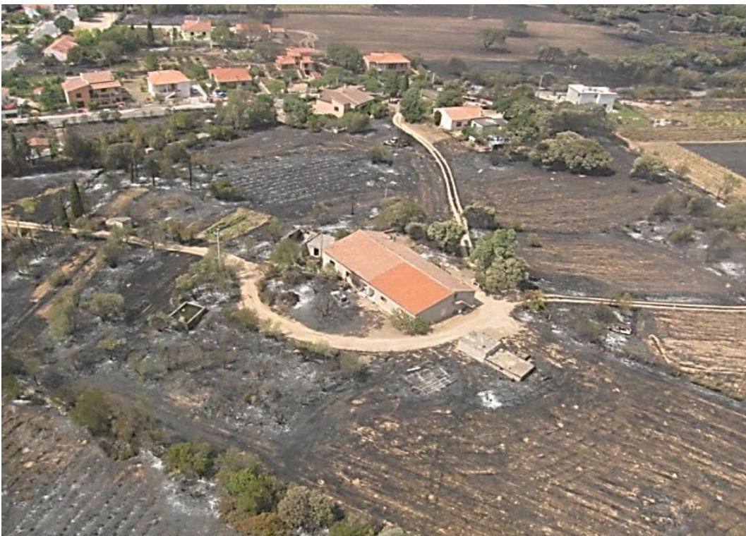
Figura 13. Struttura entrata in contatto diretto con le fiamme poiché su parte del suo perimetro non è stata ridotta la vegetazione al fine di realizzare uno spazio difendibile adeguato (fonte CFVA)
