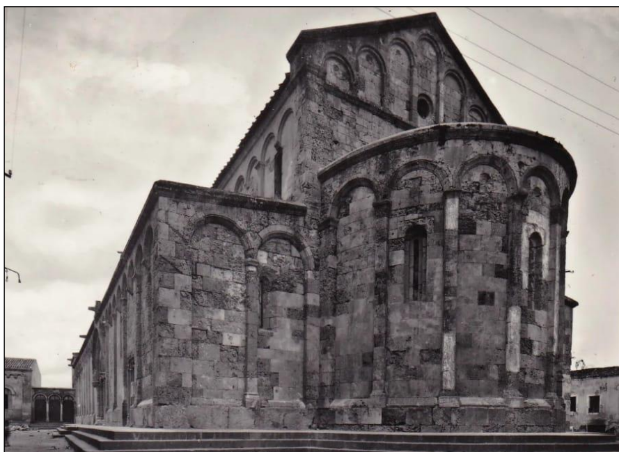
Figura 2: Basilica di San Gavino in una fotografia ‘artistica’ della prima metà del Novecento. Si veda la sacrestia (in fondo a sinistra) col passaggio scandito da due delle quattro colonne ora poste nello slargo attiguo. Attualmente, demolita la struttura, non vi è passaggio fra la chiesa e la sacrestia (coll. priv.).
