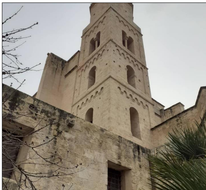
*Figura 27: Sassari, campanile medievale dell'antica pieve (ora cattedrale) di San Nicola. La parte sommitale, forse incompiuta o modificata per vetustà, risale ai rifacimenti operati tra XVII e XVIII secolo.
