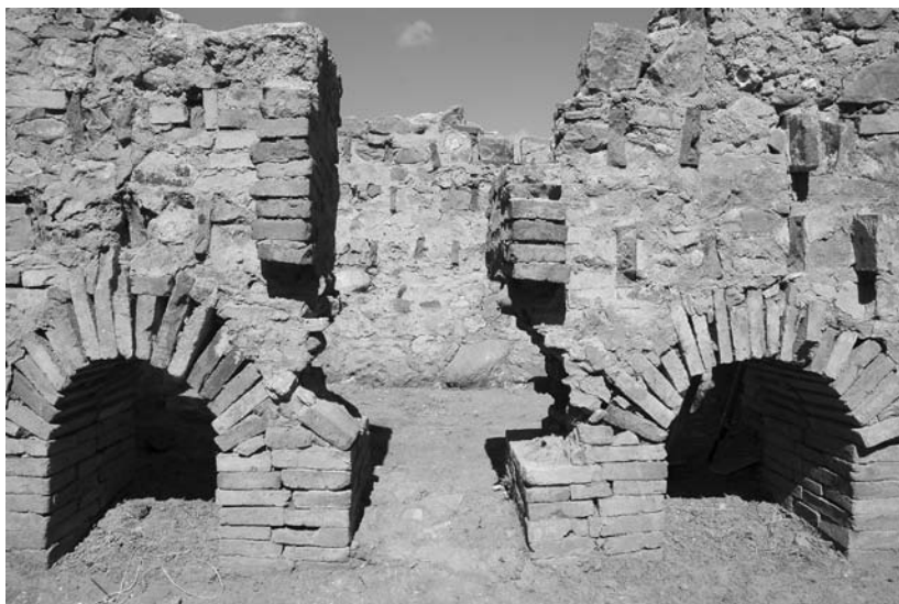
Fig. 4: Muro medianero del edificio termal, destacando las dos claves de arcos abovedados, la concameratio , así como el arranque del vano de acceso interior.
