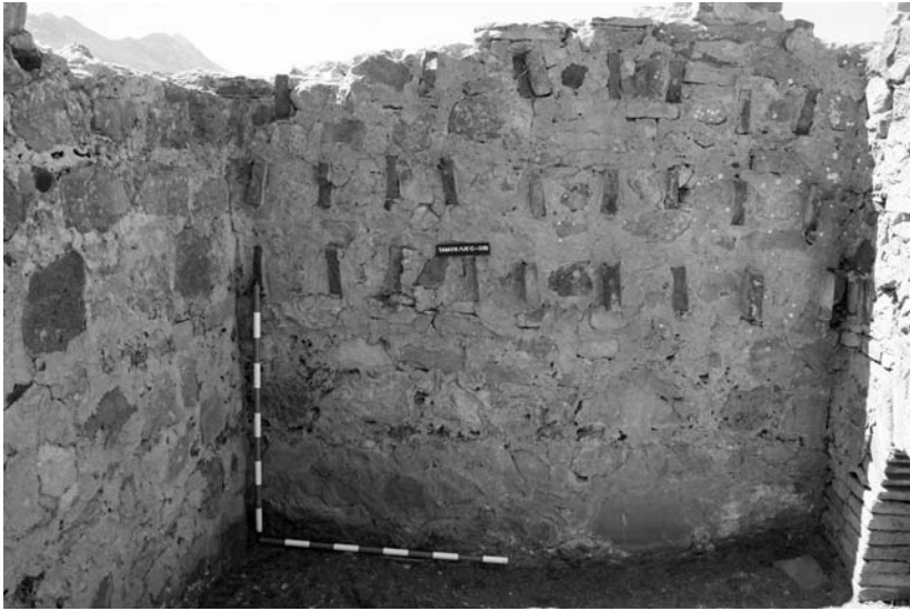
Fig. 3: Paramentos sur y este del balneum con sistema de calefacción parietal.
