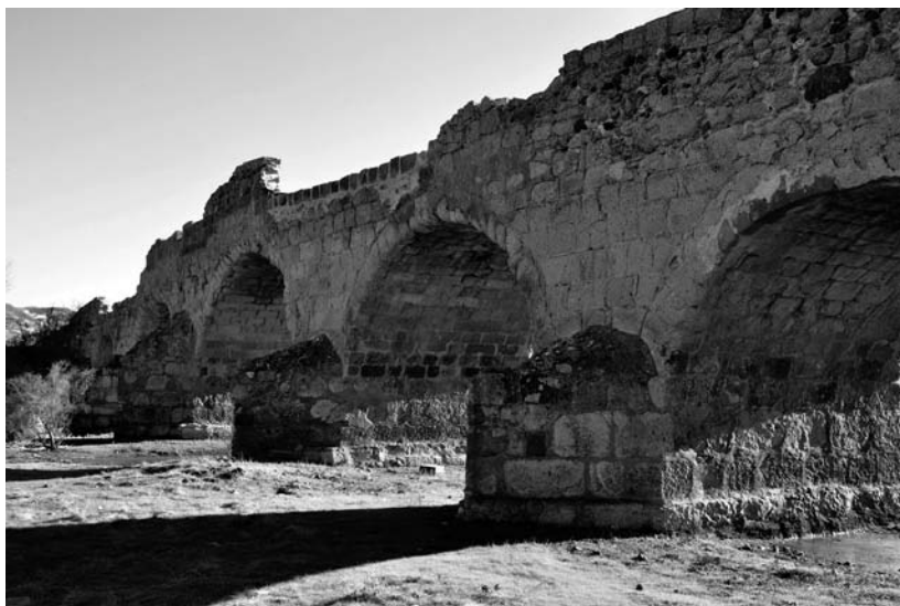
Fig. 2: Lato orientale del ponte (foto M. A. Amucano).
