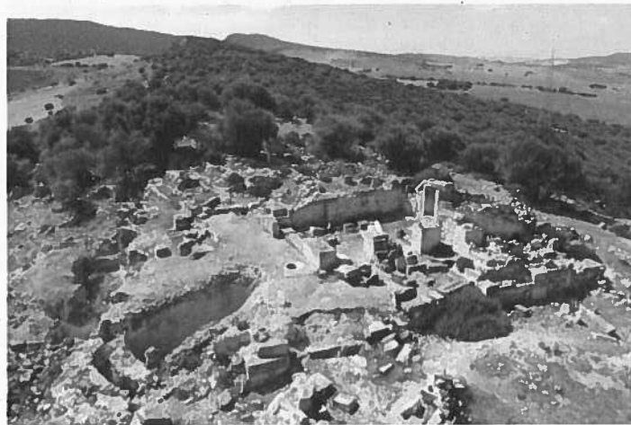
Fig. 6. Thignica . Area del "tempio di Dite e Saturno" con la grande cisterna (ortofoto di S. Ganga).
