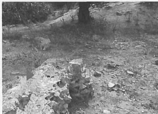
Fig. 11 A. Thignica . Segmento di condotta idrica (foto A. Mosca).
