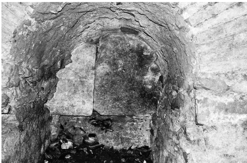
FIG. 10 Ambiente 52, blocchi di travertino pertinenti al secondo setto murario in appoggio sulla piattaforma in opera cementizia (foto M. Giagnori).
