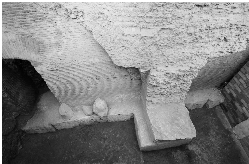
FIG. 17 Interrati sotto l'Aula consiliare, ambiente 1, strutture in opera laterizia pertinenti ai vani 1 e 2 (foto ACC).
