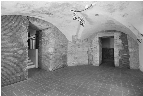
FIG. 18 Interrati sotto l’Aula consiliare, ambiente 3, muri in opera laterizia e volta in opera cementizia pertinenti al vano 3 (foto ACC).
