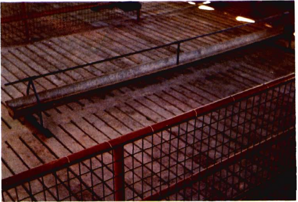
6. Pavimento fessurato in elementi di calcestruzzo. Slatted floor: concrete elements.
