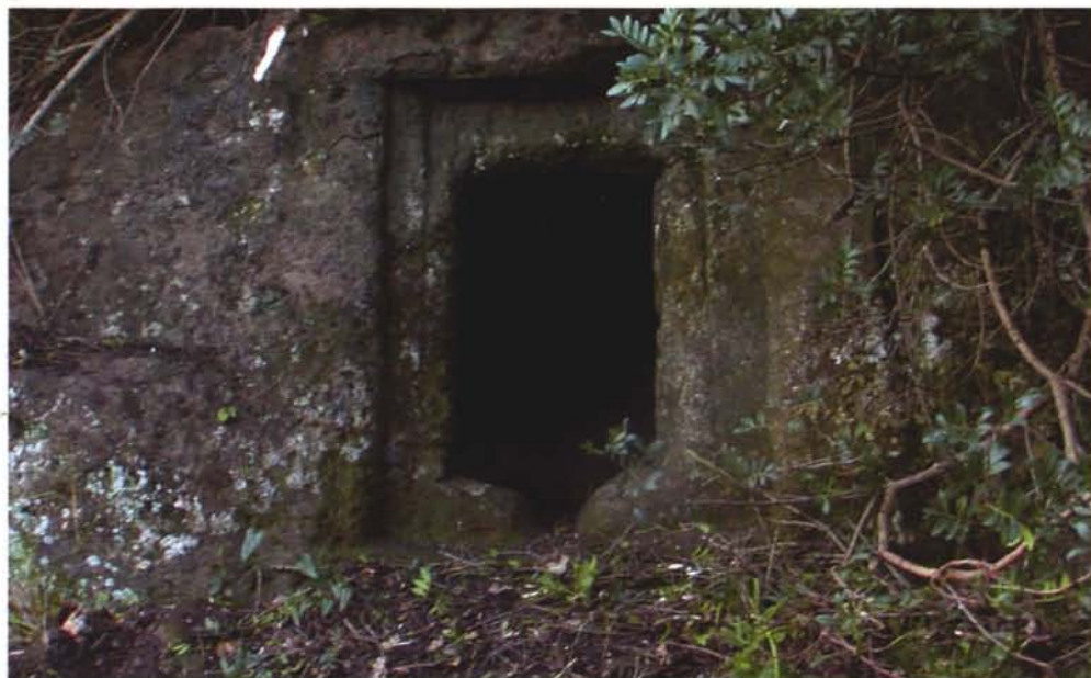
Figura 50. Tadasuni, Binza 'e Rune, portello d'ingresso dell'ipogeo 1.
