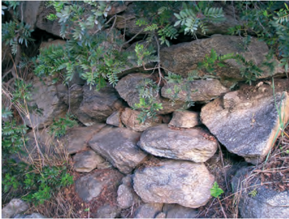
Protonuraghe Janna Bassa: paramento murario nel lato Est
