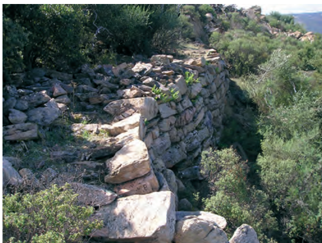
Muraglia di Monte Prana: veduta da Est del settore occidentale
