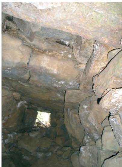
Nuraghe Thorra : corridoio di ingresso
