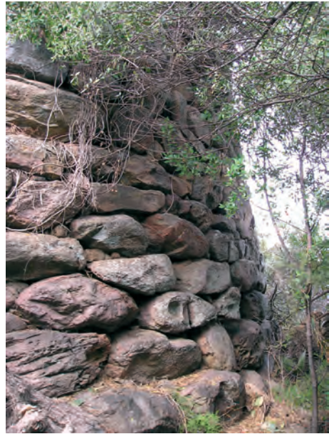
Nuraghe Sas Melas: dettaglio murature a Sud-Est
