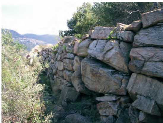
Muraglia di Monte Prana: particolare del settore occidentale
